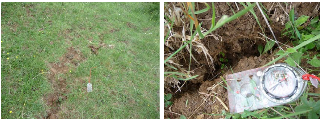
Illustration 16 : Photographies de la brèche supérieure du glissement situé à Gerbécourt.
