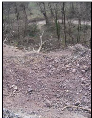
Glissement superficiel en aval de la route dans les alluvions anciennes recouvrant les argiles et gypse du Trias supérieur à Roquebillière (Alpes-Maritimes). Une partie de la route s'est effondrée lors du glissement (source : observation terrain le 28/02/08)
