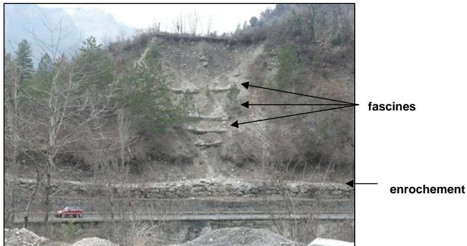
Glissement superficiel dans les alluvions anciennes talutées à Rigaud (vallée du Haut-Var, Alpes-Maritimes). Des fascines et un enrochement en pied de glissement ont été posés afin de stopper le mouvement. (source : observation terrain le 28/02/08)
