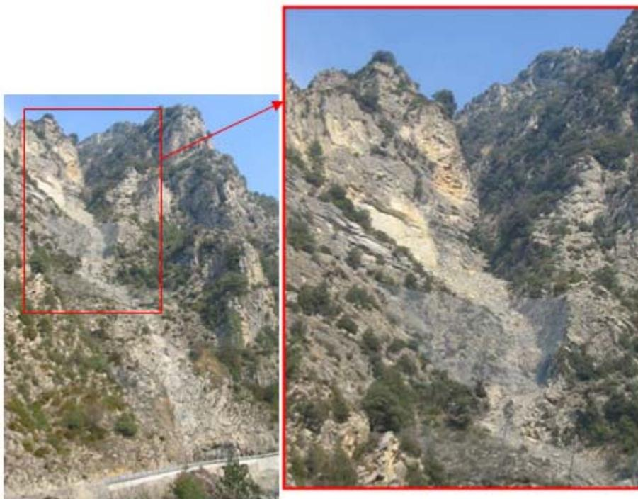
Vue après les travaux de protection. Un écran dynamique arrête les blocs dans le couloir d'éboulis et un grillage plaqué a été posé à même la paroi rocheuse.
