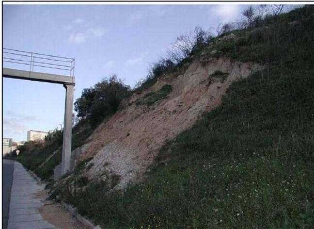
Glissement superficiel dans les remblais recouvrant les alluvions et terrasses du Quaternaire suite à de fortes pluies. Décembre 2003, le long de l'autoroute A7 à Marseille (source BD mvt)
