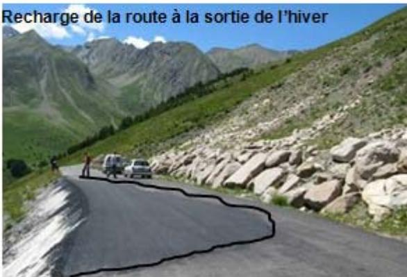
Glissement type solifluxion dans les moraines du col d'Allos (vallée du Haut-Verdon, Alpes de Haute-Provence). A chaque sortie d'hiver, le réseau routier nécessite un entretien (recharge) récurrent (source : CG04)
