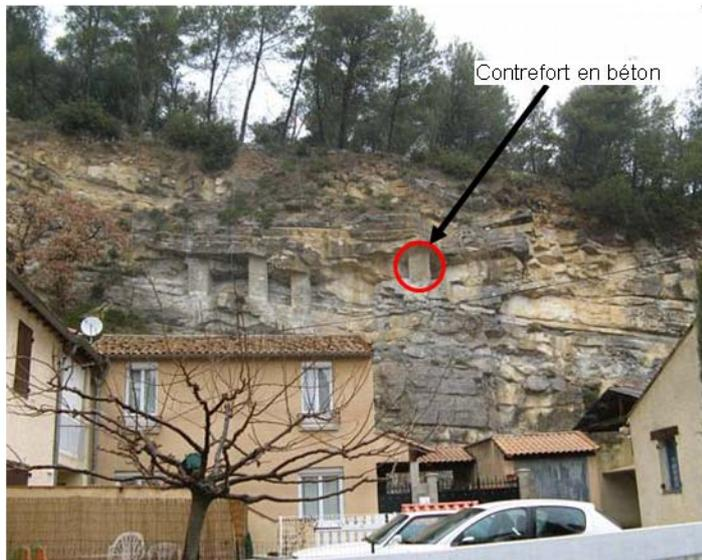
Les maisons sont directement exposées aux chutes de blocs (calcaires argileux du Barrémien - Jurassique inférieur). Des contreforts en béton, des boulons d'ancrage et des grillages de protection partiellement plaqués ont été installés pour sécuriser la maison. Lieu : Vaison-la-Romaine, Vaucluse. Source : BDMVT
