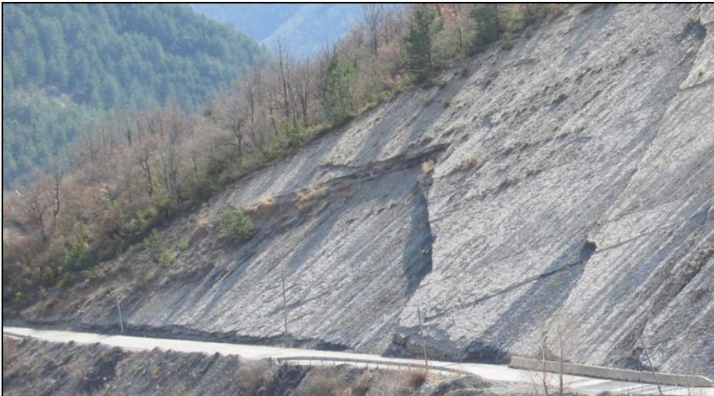
Chutes de blocs récurrentes le long de la D20 en montant vers le Col du Corobin (Alpes de Haute-Provence). Les marnes calcaires affleurent en bancs réguliers dont le pendage parallèle à la pente favorise la chute des blocs par glissement banc sur banc. (source : CG04)
