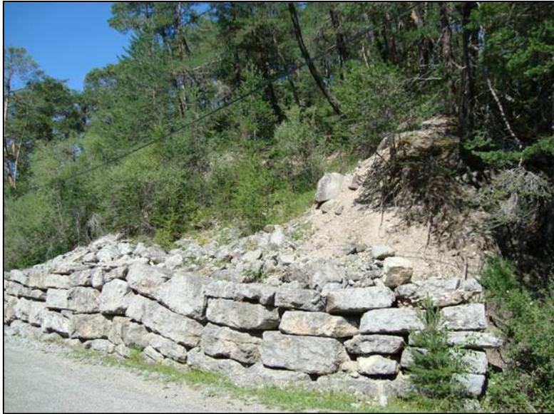
Glissement superficiel le long d'un talus routier à Beauvezer (Alpes de Haute-Provence). Les marnes noires du Crétacé sont recouvertes de dépôts glaciaires qui glissent le long de la surface de contact entre les deux formations. Les arbres inclinés témoignent du mouvement gravitaire. Un enrochement a été posé afin de stopper le mouvement et l'encombrement de la voirie (source : CG04).
