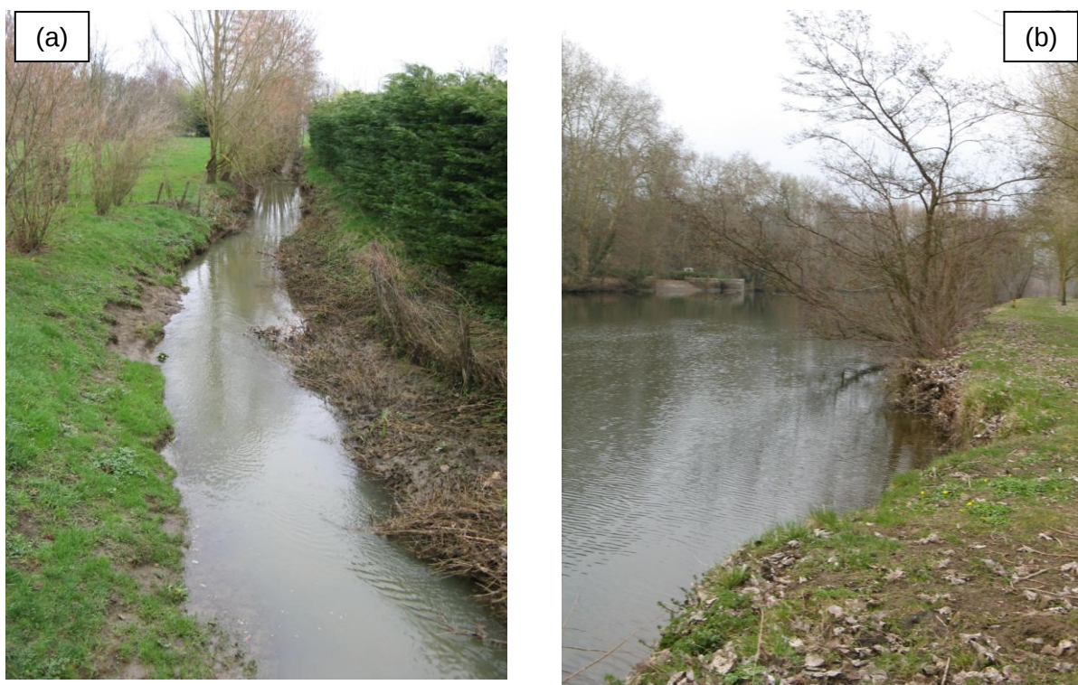
Illustration 28- Erosion des berges de la Sarthe sur la commune de Courcival (a) et de Malicorne (b) (photo BRGM, 2011)
