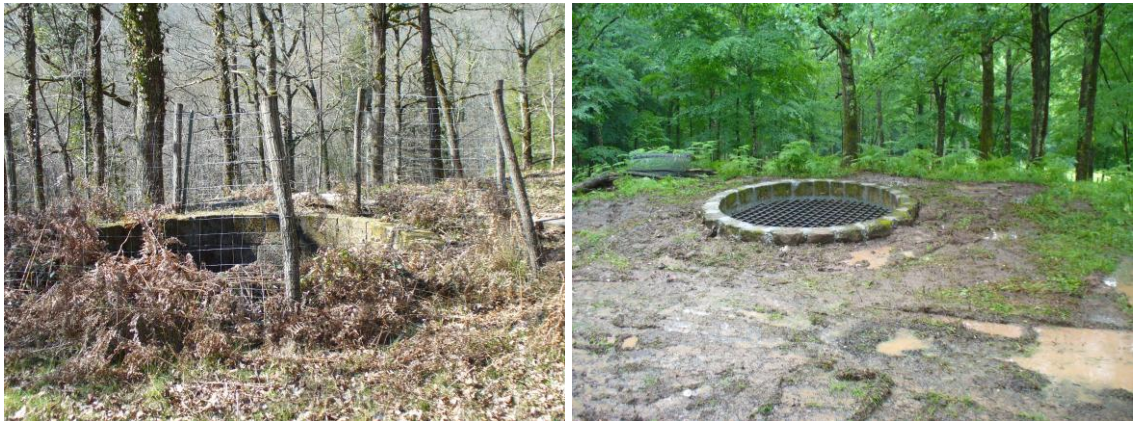
Illustration 10 - Puits Albert avant et après travaux.
