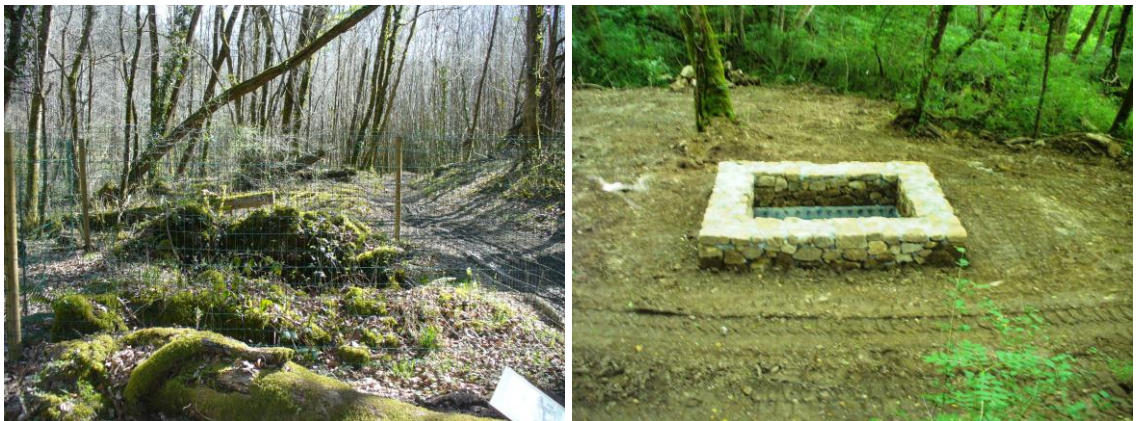
Illustration 12 - Puits Vieux avant et après travaux.
