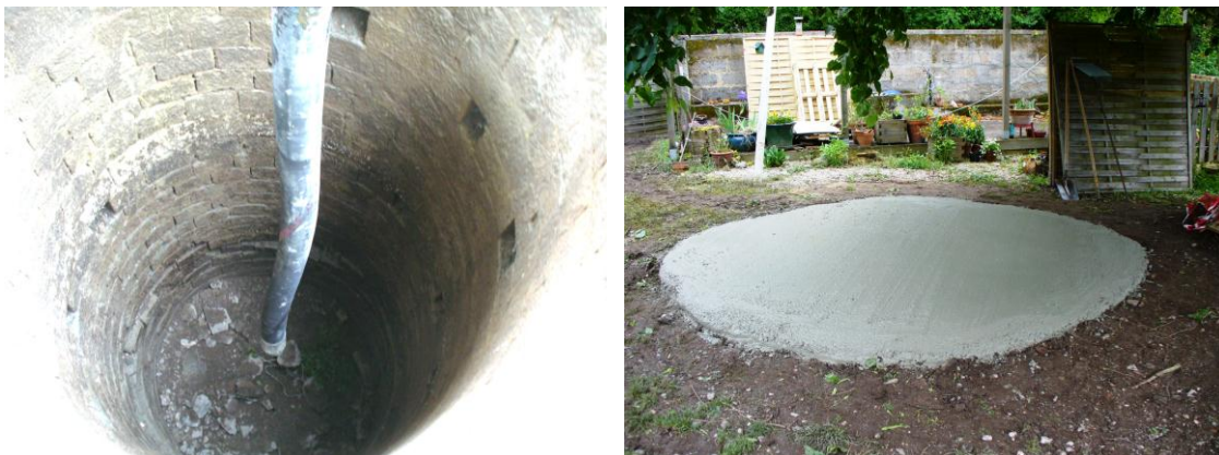
Illustration 9 - Puits Sainte-Barbe avant et après mise en place du bouchon-
