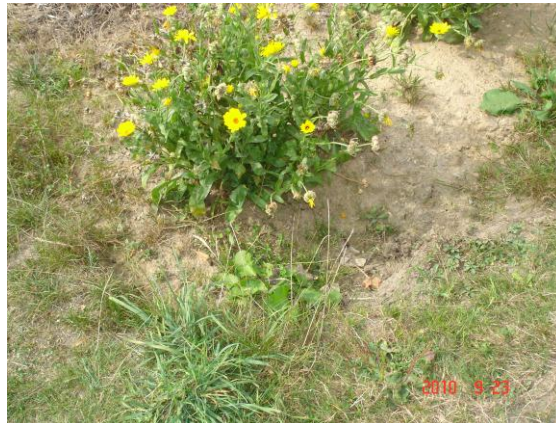
Illustration 7 - Vue du tassement en septembre 2010.
