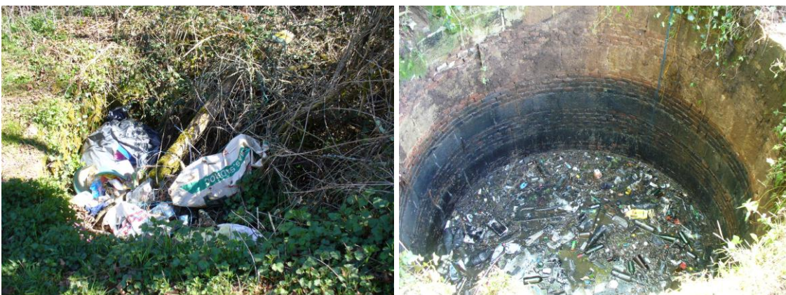
Illustration 15 - Puits de La Valade avant travaux et pendant l'enlèvement des débris.
