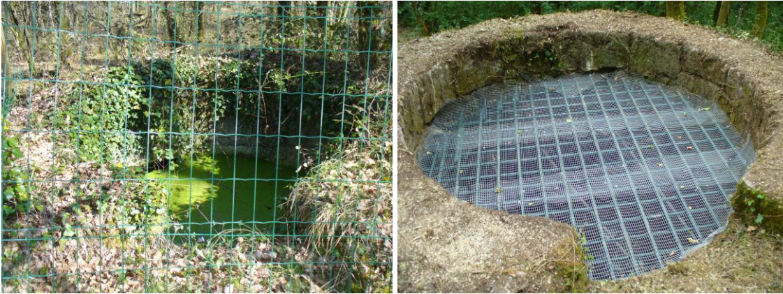
Illustration 13 - Puits de l'Espérance avant et après travaux.
