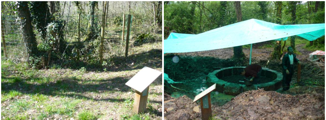
Illustration 11 - Puits Festugère avant et pendant les travaux.
