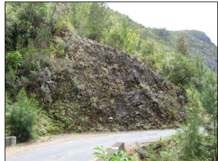
Escarpement rocheux en rive gauche de la Ravine Coin
