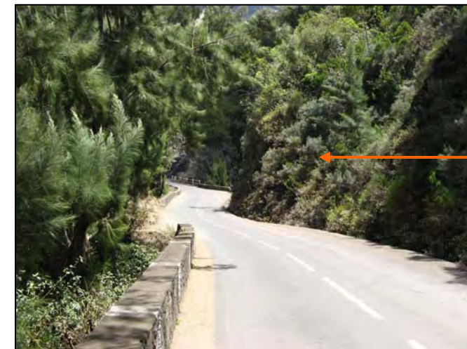
Talus amont en rive gauche
