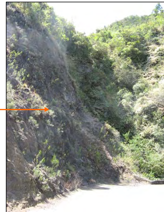
Combe et trace de fluage dans les terrains créés par un ravinement superficiel
