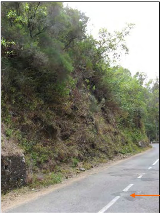
Rive droite, partie 1 : arrêt du mur de soutènement
