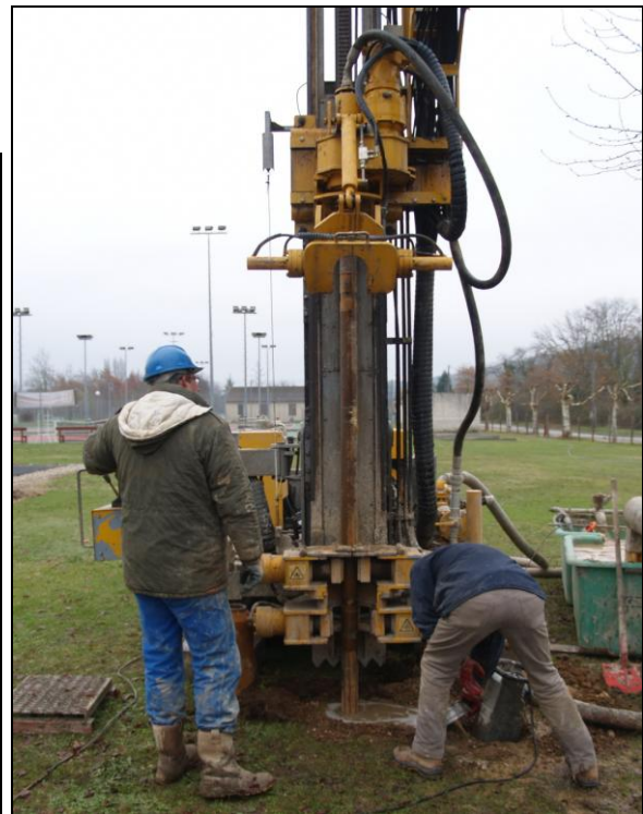
Illustrations 5 et 6 : Détail de l'outil (tricone 8 n / 2 ) et foration
