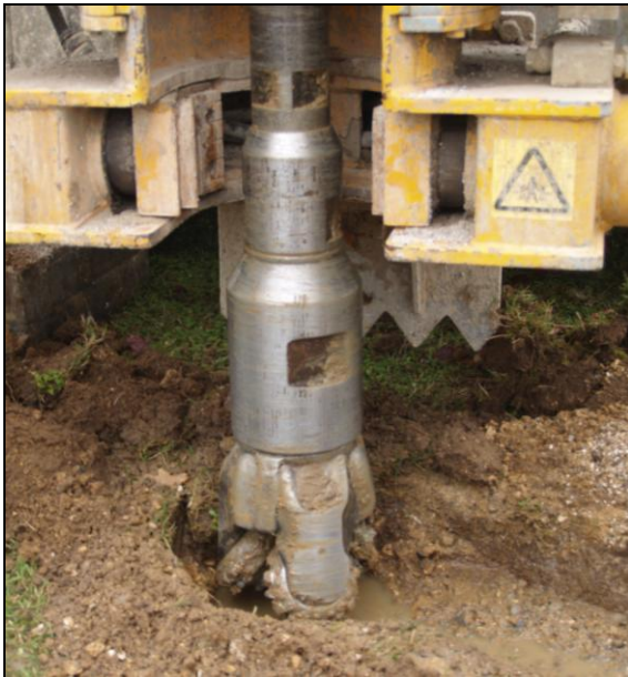
Illustrations 5 et 6 : Détail de l'outil (tricone 8 n / 2 ) et foration
