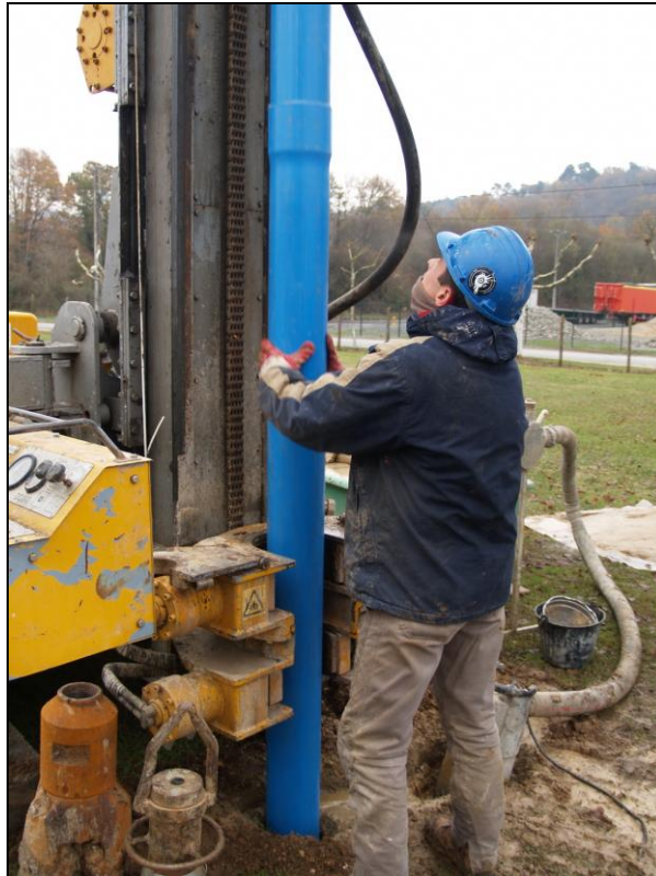
Illustration 9 : Pose du tubage et de la crépine PVC 6"
