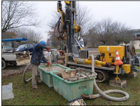
Illustration 4 : Vue du chantier et préparation de la boue de forage
