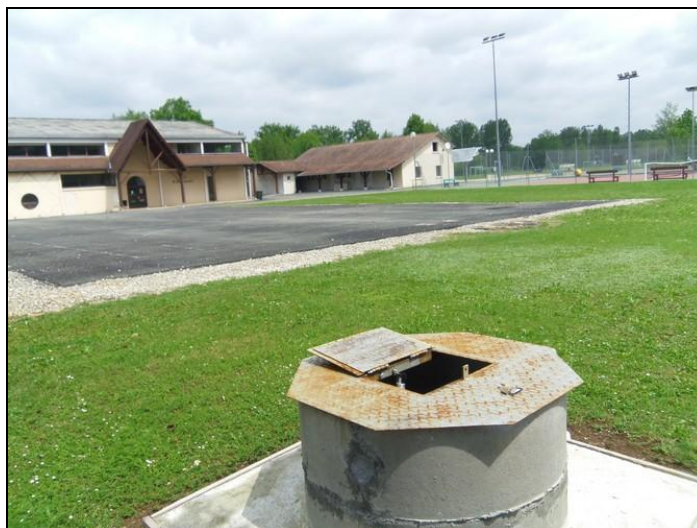
Illustration 15 : Aménagement réalisé autour du forage
