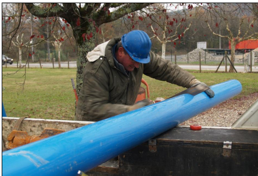
Illustration 7 : Préparation du tubage et de la crépine PVC 6"(157 – 167 mm)
