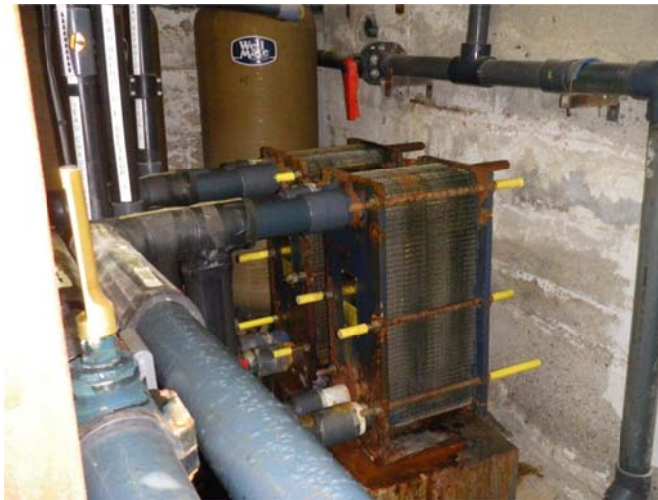
Illustration 20 : Échangeur à plaques
