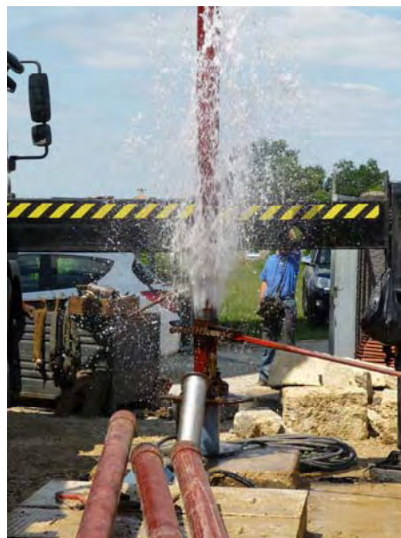
Illustration 64 : Démontage des tubes de la colonne d'exhaure.
