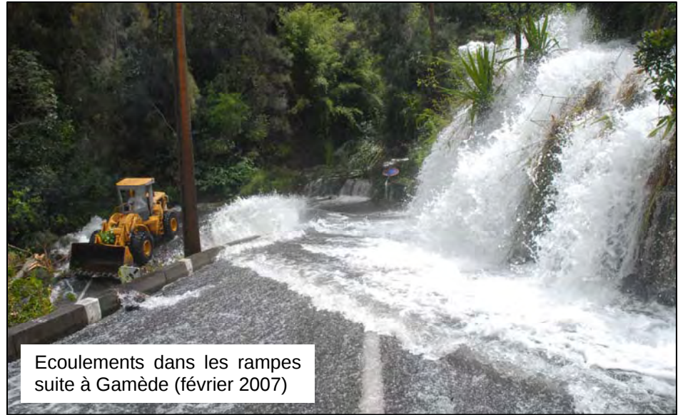
Partie inférieure des rampes
