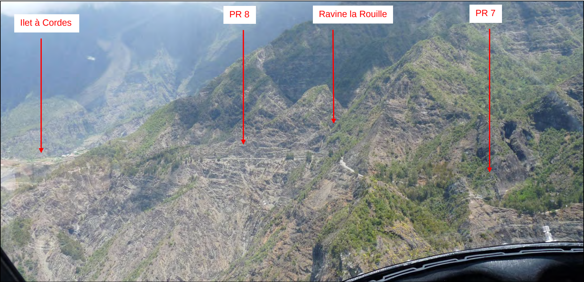
Figure 4 : Vue générale du contexte morphologique de la RD242, approximativement entre le PR 7 et le PR 9
