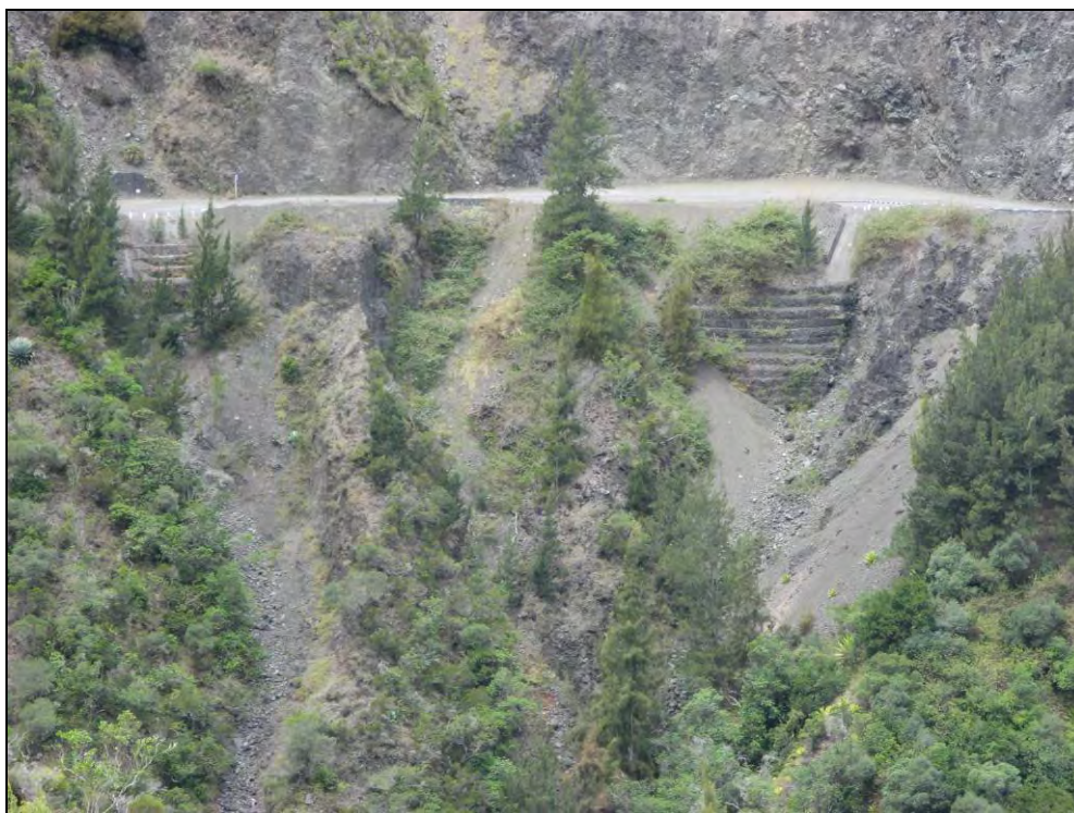
Figure 27 : Processus érosifs affectant le versant aval au niveau de Cap Tuf
