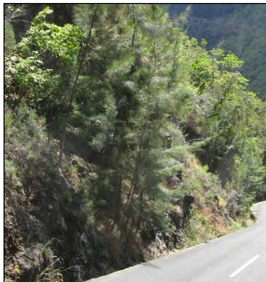
Figure 17 : Dépôts de colluvions de pente, PR 4 + 400
