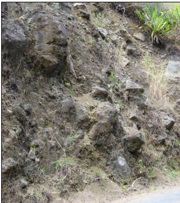
Figure 18 : Formations de colluvions de pente, PR 3
