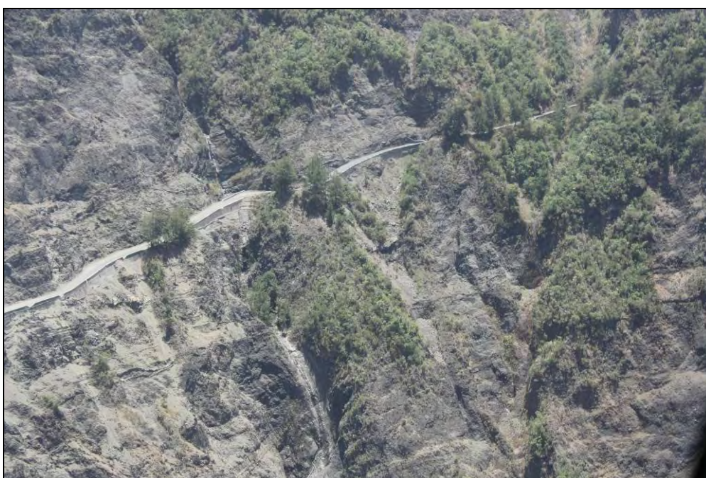
Figure 28 : Processus érosifs affectant le versant aval au niveau du Cap la Rouille
