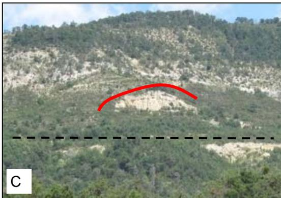
Glissement dans la frange altérée des grés glauconieux Crétacé supérieur. L'évènement s'est produit dans les années 1970 sur la commune de Châteauvieux (Var). Plusieurs milliers de mètre cubes sont entrés en mouvement. Le tracé de la RN85 a du être dévié. Photo A : route actuelle et zone de départ du glissement en amont. Photo B : ancienne route complètement déformée. Photo : C : vue d'ensemble (en tiretés noirs tracé de la route actuelle). Source : CG04,
