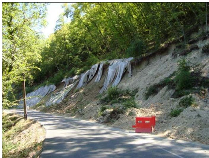
Glissement dans les marnes et sables du Pliocène le long de la RD101 sur la commune de Le Broc (Alpes-Maritimes). La surface de glissement a été recouverte de géomembrane dans le but de limiter les écoulements superficiels. Source : CG06
