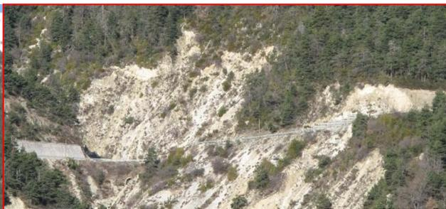
Glissement dans les marnes et calcaires altérés du Crétacé supérieur observé sur la commune de Méailles (Alpes de Haute-Provence). Un premier évènement eut lieu en 1956 emportant la chaussée sur 150 m. Suivi d'un deuxième glissement en février 1959. (source RTM04).
