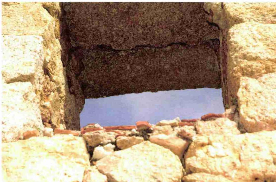
*Illustration 180 - Mulinaghju : une fenêtre intérieure soulignée par un lit de plaquettes d'argile cuite.*
