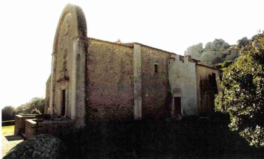
*Illustration 169 - Façades est et nord du sanctuaire, avec le gros appareil en quadri de granite et les piliers en calcaire du Piaie.*
