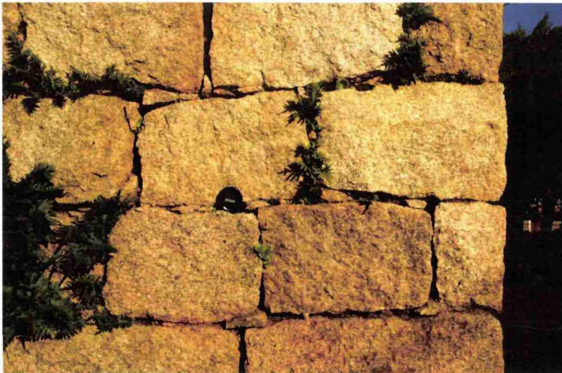
*Illustration 117 - Détail du granite en œuvre à Chera : on remarque l'utilisation de la Terra Rossa au niveau de certains joints et des éclats de granite pour caler les quadri.*
