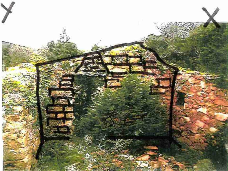
*Illustration 94 - Croquis explicatif de la photo précédente : remarquer le gros appareil relativement bien réglé de la cloison intérieure, faite de quadri assez bien équarris, qui contraste avec le mortier de remplissage qui semble boucher un ancien trou au-dessus du linteau en bois de la porte de communication*
