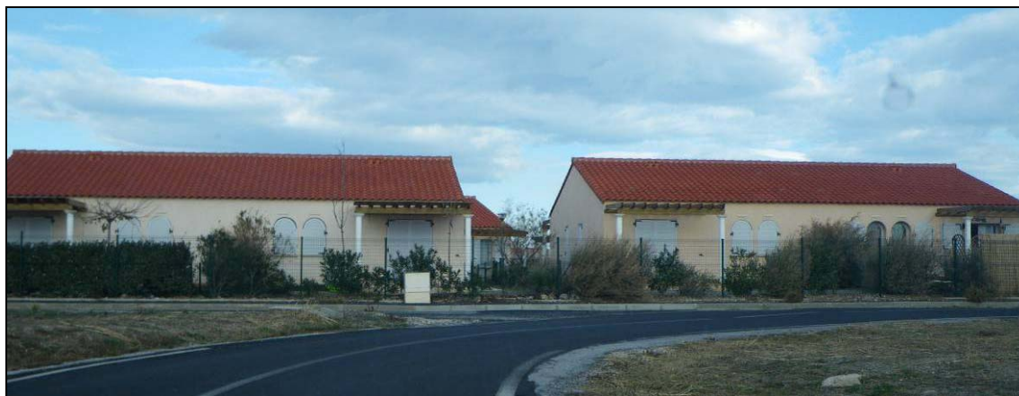
Figure 31 : Exemple de bâtiments d'un seul niveau de type 4 à Leucate.
