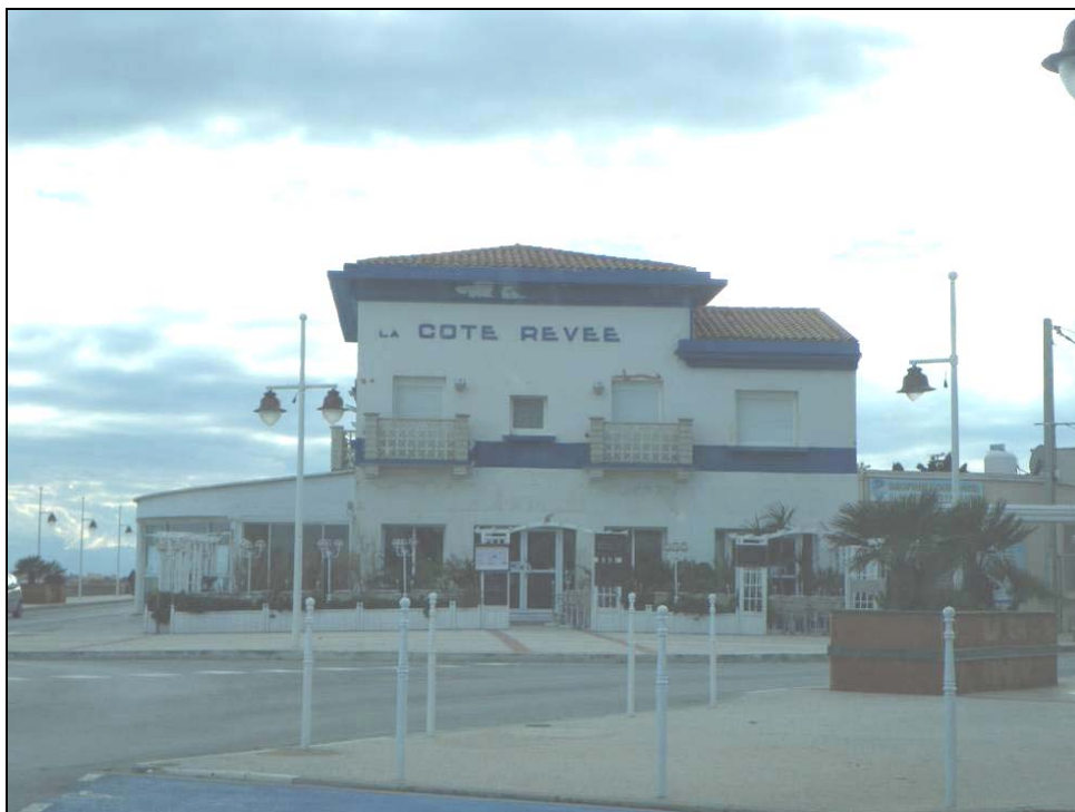
Figure 27 : Exemple de maison individuelle avec un étage et un restaurant en terrasse (type 1), à Leucate-plage.
