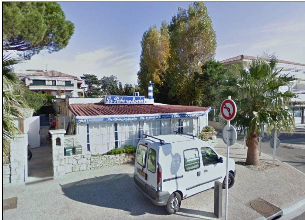
Figure 19 : Exemple de bâtiment d'un seul niveau, de type 3, avec des grandes ouvertures en front de mer à Six-fours-les-plages (extrait de Google Street View ©).
