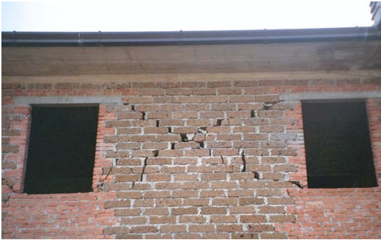
Figure 2 - Mécanisme de cisaillement (d'après Lagomarsino et al., 2006) et courbe expérimentale de chargement cyclique
