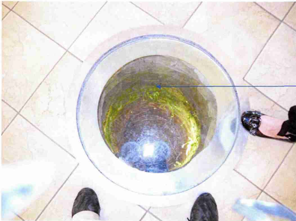
Illustration 5 – Puits captant les alluvions du Vert dans l'Office de Tourisme
