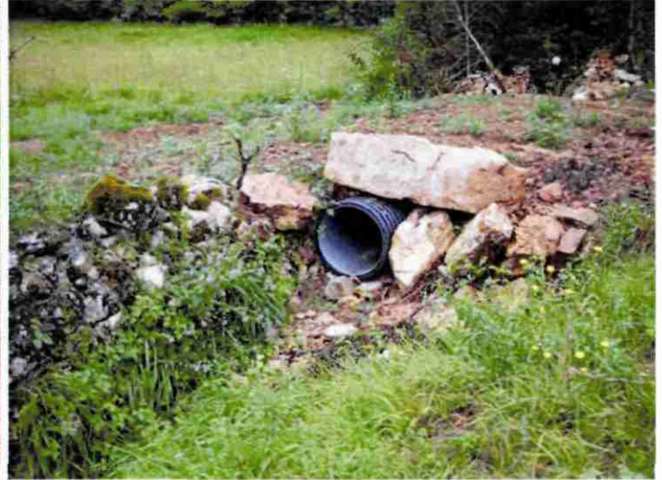
Vue en aval de la buse
