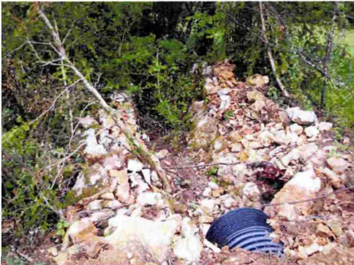
Dépôts de blocs calcaires en amont de la buse
