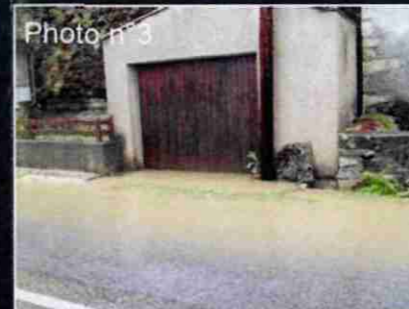
Cave inondée par les eaux de Font d'Egre
