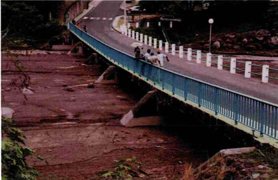
Illustration 11 : Lave torrentielle en janvier 1998 au niveau du pont du Prêcheur
