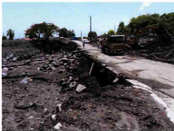
Vue aval du pont montrant les dégâts occasionnés à la structure
