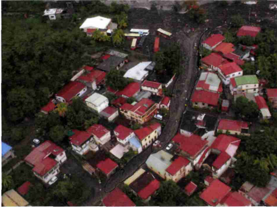
Illustration 10 : Inondation de la route à travers le quartier – photo prise le 20 juin (source : Sanchez)
