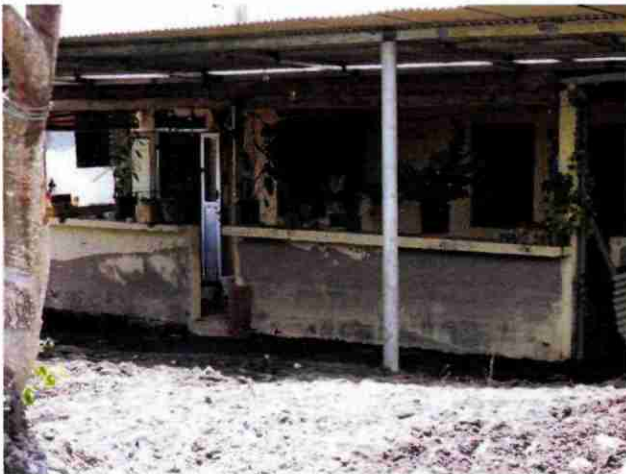
Laisse sur le muret de la maison n°5. La boue est passée derrière, bloquant les portes Laisse sur le mur extérieur de la maison n°5
