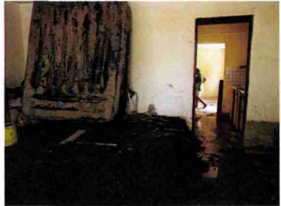
Dépôt de boue à l'intérieur de la maison n°6
