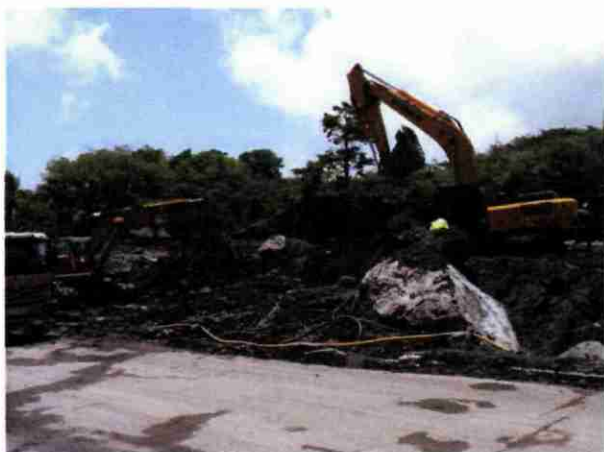
Vue amont du pont avec le lit de la rivière totalement comblé
