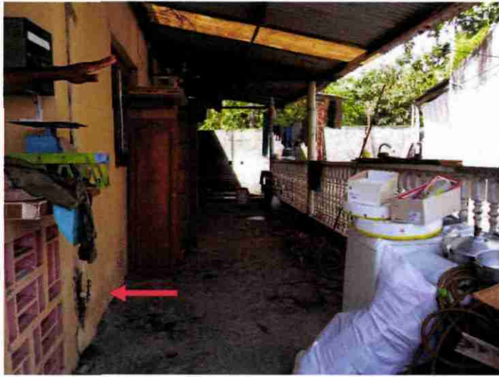
Au fond, mur en maçonnerie qui a protégé les habitations n°7 et 10
