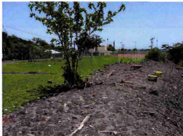
Les laves torrentielles ont atteint la tête de la berge sans la submerger
