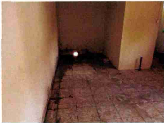
Ouverture faite dans le mur pour évacuer l'eau
