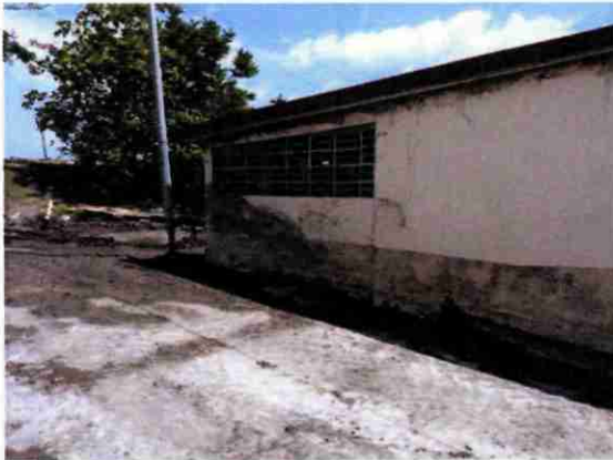
Laisse sur le mur extérieur de la maison n°6
