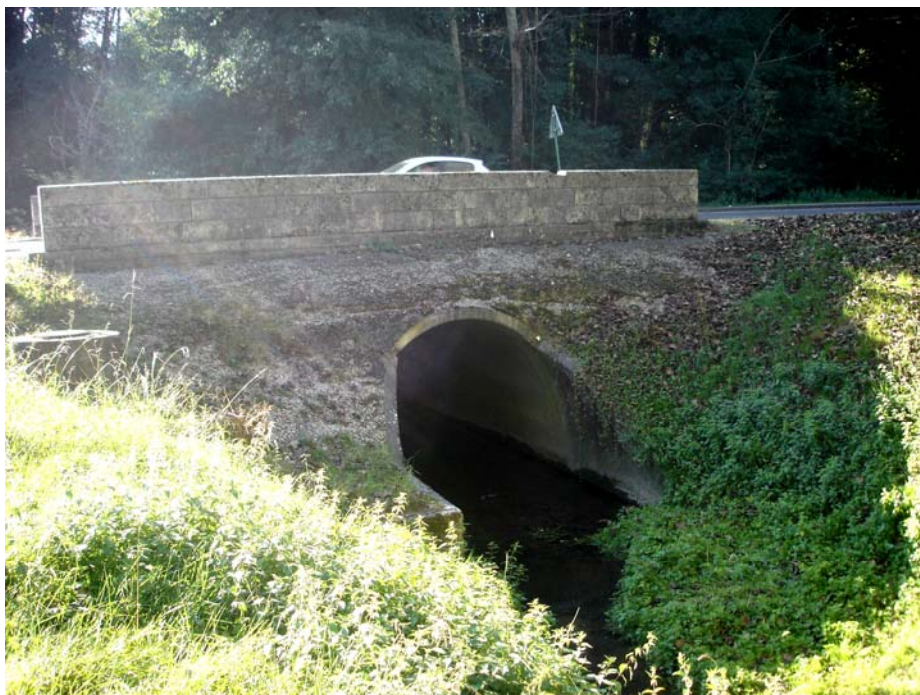
Illustration 18 : Site d'implantation de la station de Sadirac
