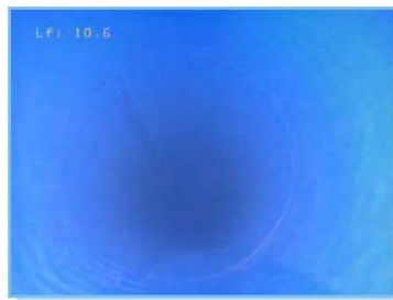
Tube en PVC - diamètre 180 mm aspect annelé des parois
