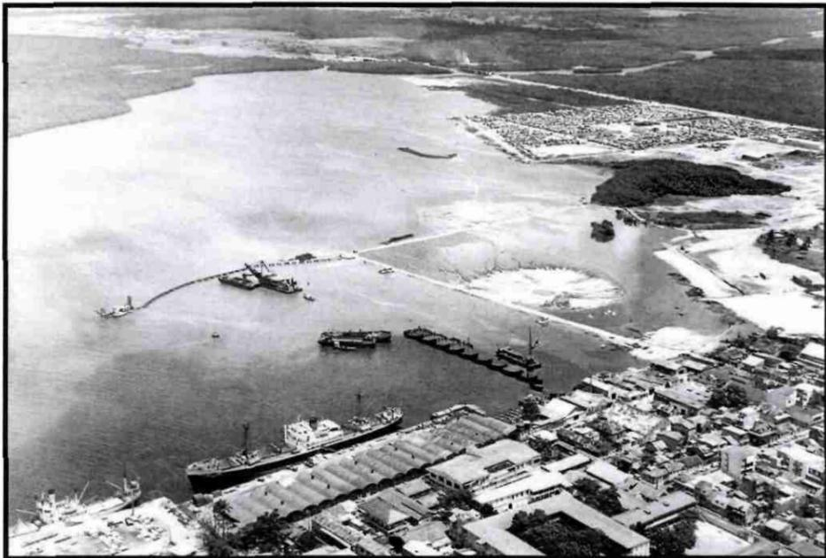
Illustration 35 : Construction des Quais de Bergevin - Pointe-à-Pitre (1960). Source PAG. Remblaiement sur 20 ha environ.
