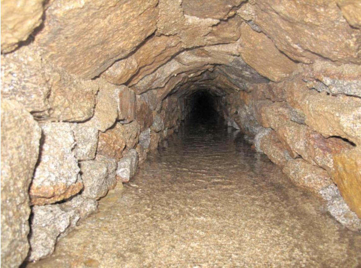
Illustration 4 - Photographie de l'intérieur du drain n°2 à l'amont du regard 163 (profondeur 4 m)
