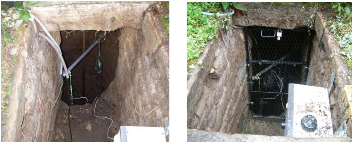
*Illustration 9 : Sécurisation du puits de Terre-Natale (photo de gauche : avant travaux ; photo de droite : après travaux)*
