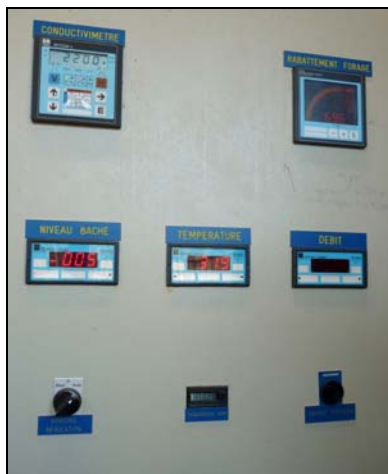
Illustration 26 : Tableau des afficheurs du suivi qualité et tête de forage
