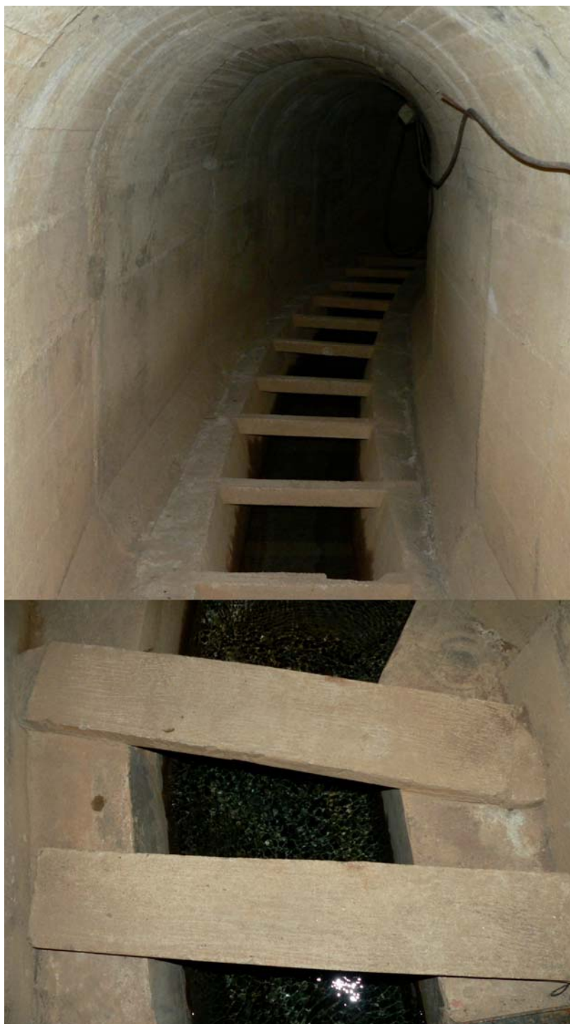
Illustration 33 : Vue de la galerie depuis la chambre de captage (de la partie aval vers l'amont), avec détail de l'emplacement projeté pour la centrale d'acquisition.
