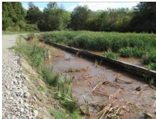
Illustration 5 - Station de traitement des eaux à Buxières-les-Mines (03)
