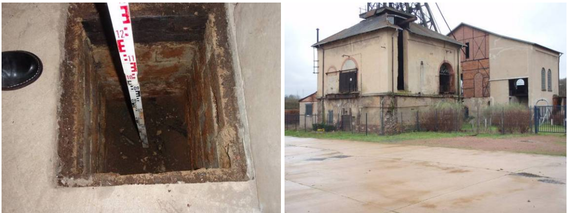
Illustration 75 - La trappe du puits Vuillemin 1 - Le bâtiment recette Vuillemin 2.
