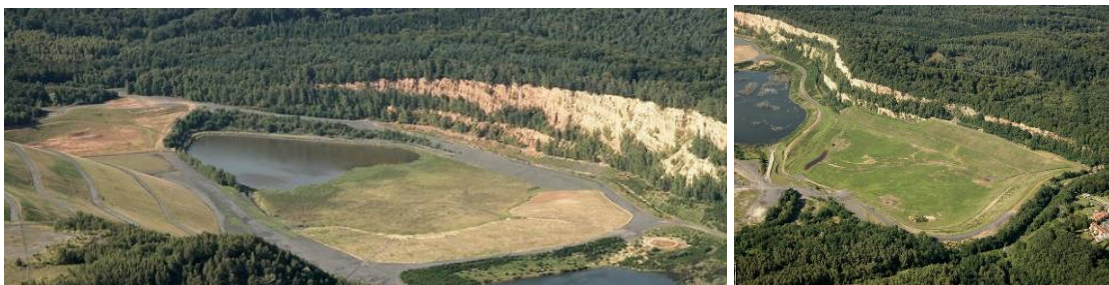
Illustration 132 - Le bassin de décantation et le schistier du Warndt.
