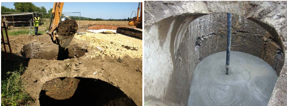
Illustration 116 - Excavation des remblais à la pelle grand bras - le coulage du bouchon de béton.
