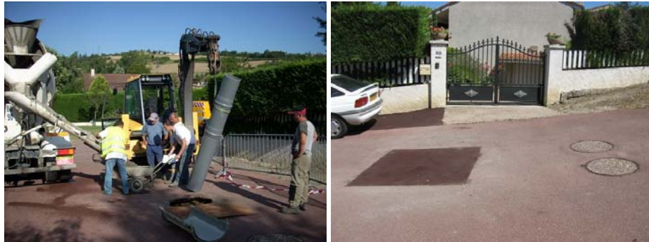
Illustration 109 - Traitement du puits Saint-Martin-la-Plaine.
