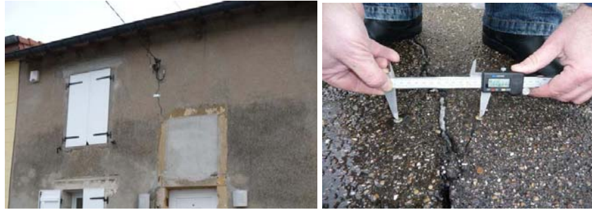
Illustration 56 - Fissuromètre installé en façade – Surveillance d'une fissure de chaussée.
