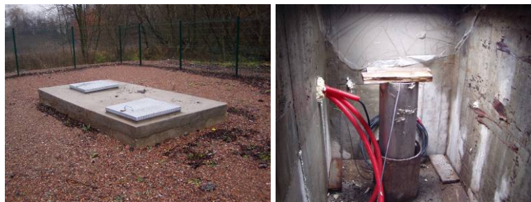
Illustration 17 - La fosse du forage Varsberg - La tête du forage.
