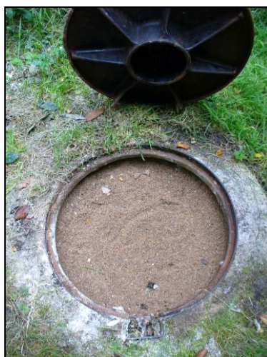
Illustration 98 - Piézomètre de Laugerette (71) - Travaux.
