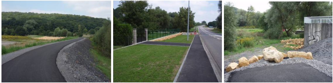
Illustration 26 - La digue – Le mur le long de la RN3 – Le lit de la rivière derrière le poste anti-crues.
