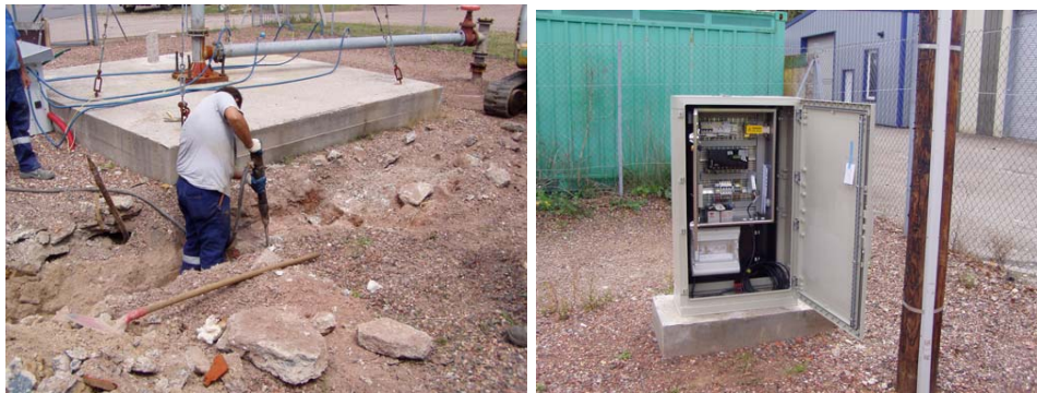
Illustration 124 - Creusement de la tranchée - armoire de télégestion.
