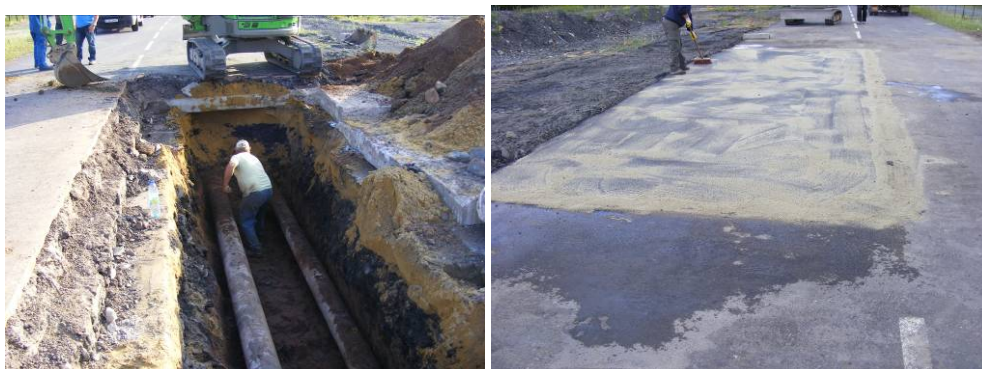
Illustration 73 - Travaux de réparation sur la conduite en juin 2009.
