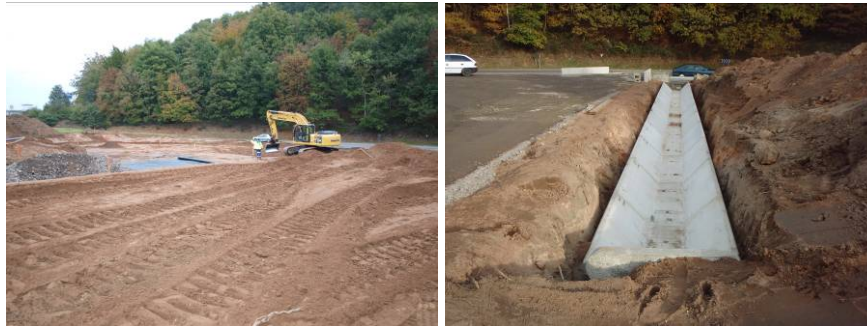
Illustration 22 - Aménagement de la piste d'accès depuis la bretelle de l'échangeur.
