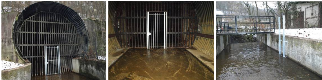
Illustration 16 - Les portails posés dans les deux grille d'accès – L'échelle d'accès au chenal.
