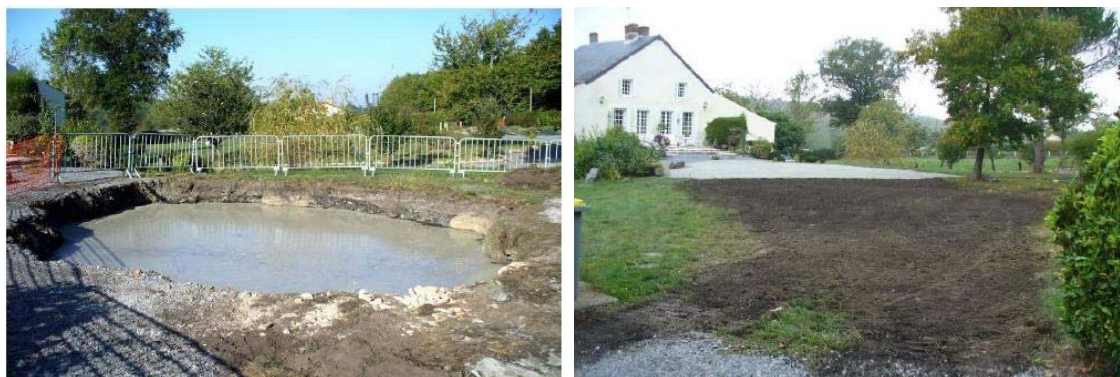
Illustration 104 - Dalle de béton dans le fontis -Vue du site après travaux à Faymoreau (85)
