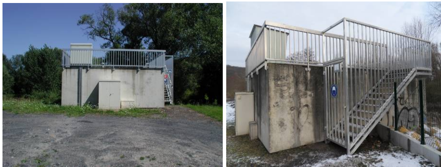
Illustration 25 - Le poste anti-crues de Rosbruck - L'escalier d'accès.
