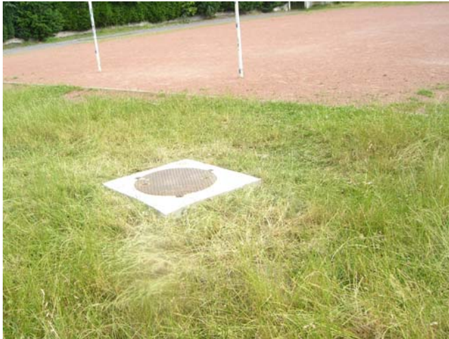
Illustration 37 - Chabaud la Tour à CONDE sur ESCAUT (59) Tête de puits matérialisée.
