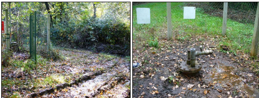
Illustration 97- Émergence de l'Ouche (71) - Travaux.
