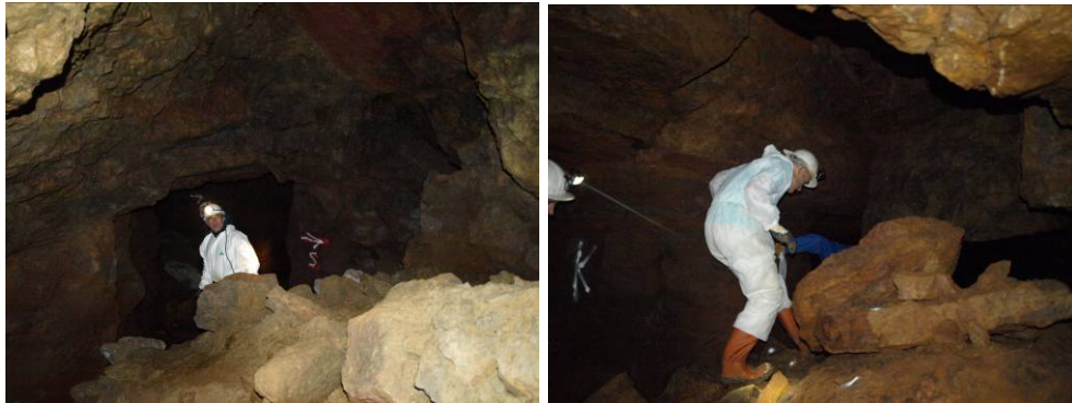
Illustration 49 - Galeries de Franchepré : blocs tombés du toit.
