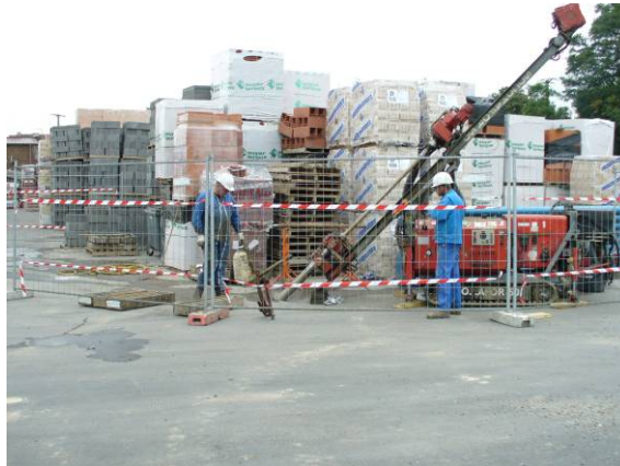
Illustration 83 - Vendin : puits A et B sur le carreau d'une entreprise.
