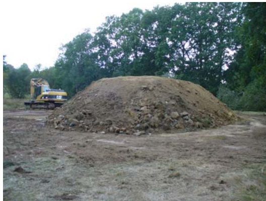
Illustration 92 - Dôme sur puits du Bois Neuf Nord remblayé à Vieux-Vy (35).
