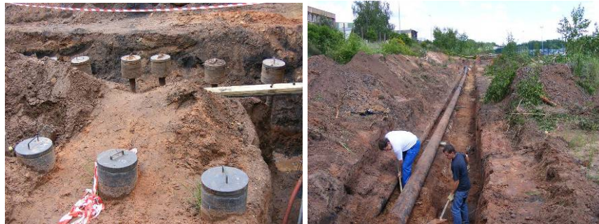
Illustration 72 - Déséquipement du poste de détente Marienau – Remplacement d'un tronçon de conduite.
