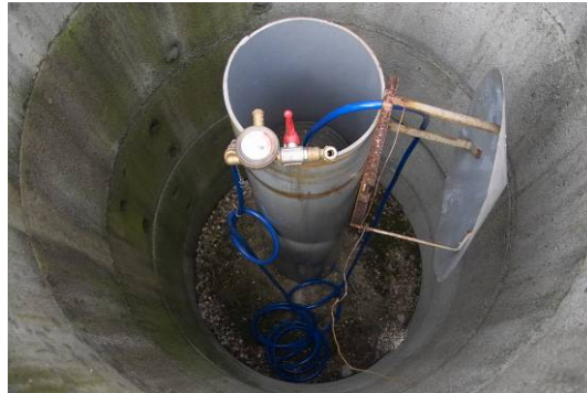
Illustration 130 - La cheminée du gazomètre.
