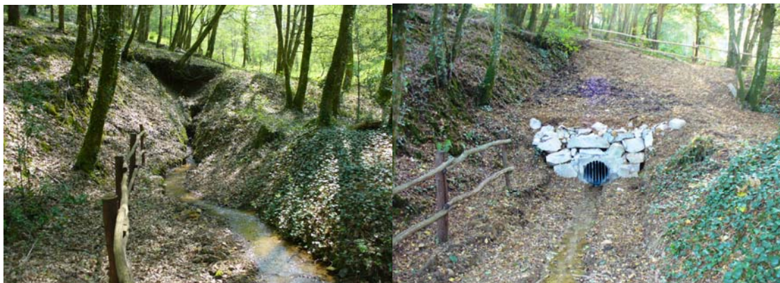
Illustration 93 - Galerie d'exhaure avant et après travaux à Chanac (19).
