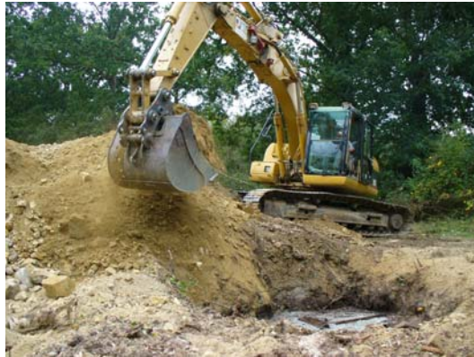
Illustration 91 - Remblaiement du puits.
