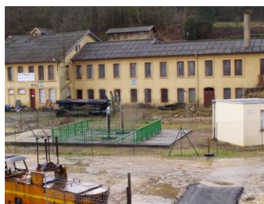
Illustration 9 - L'ouvrage amont et le local technique de Moyeuivre-Grande.
