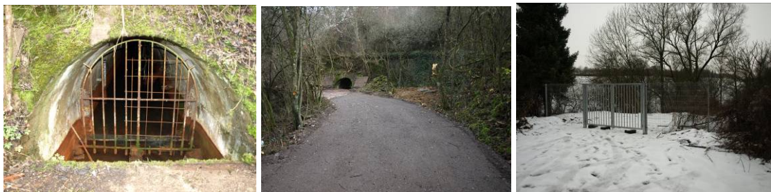
Illustration 13 - Entrée de la galerie du Woigot – piste d'accès – portail d'accès.
