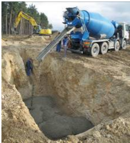
Illustration 90 - Traitement de puits – Monistrol-sur-Loire.
