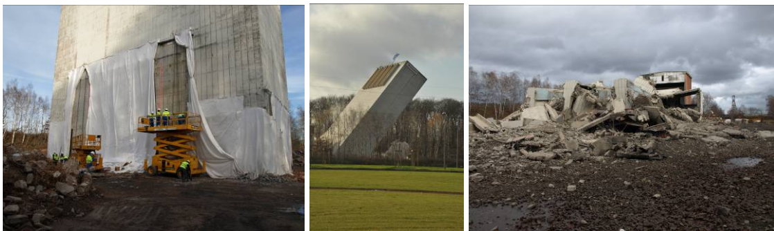
Illustration 122 - Le minage – le tir – la tour au sol le 26 novembre 2009.
