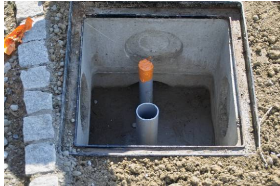
Illustration 70 - Le regard de la sonde à Belle-Roche.
