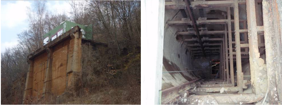
Illustration 55 - La tête du puits Ottange 2 – L'intérieur du puits.
