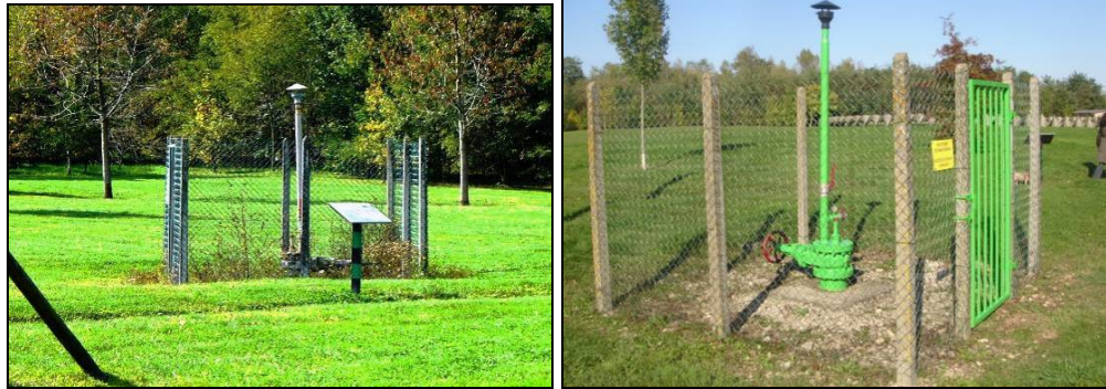
Illustration 99 - Exutoire de Maugrand (71), avant et après travaux.
