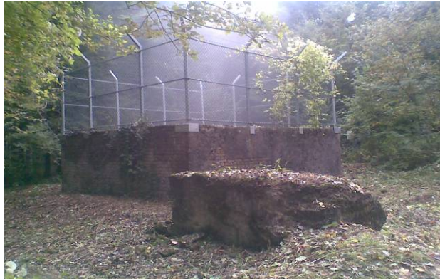
Illustration 53 - Débroussaillage du puits François.
