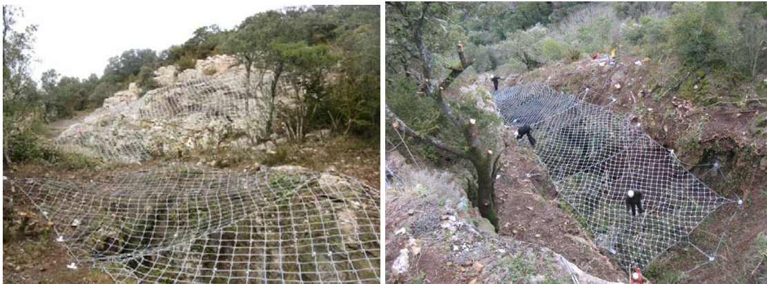
Illustration 110 - Pose de filets et excavation sécurisée.
