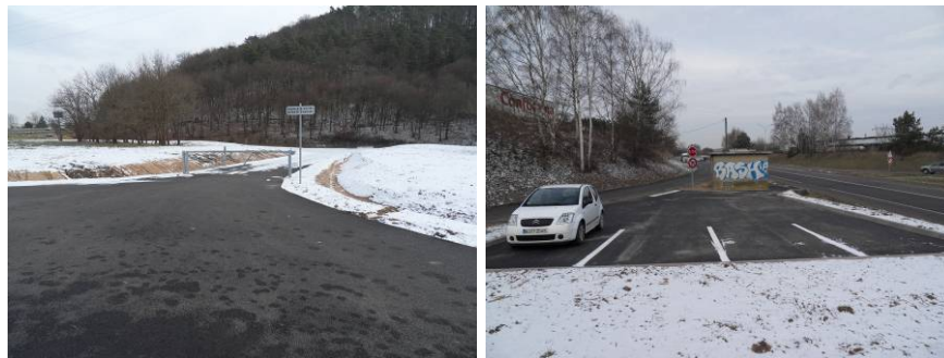
Illustration 23 - Les travaux terminés, la piste d'accès, le parking du local électrique.
