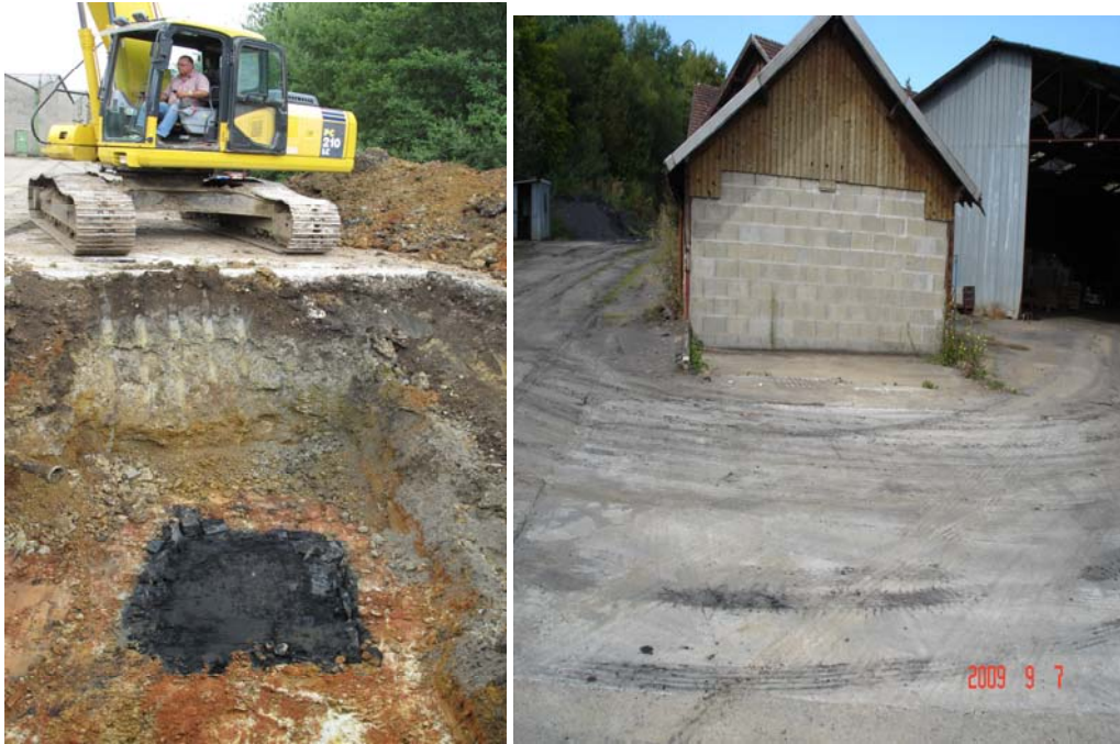
Illustration 103 - Vue du remblai du puits lors de l'excavation. Vue de la dalle après travaux à Port-Brillet (53).
