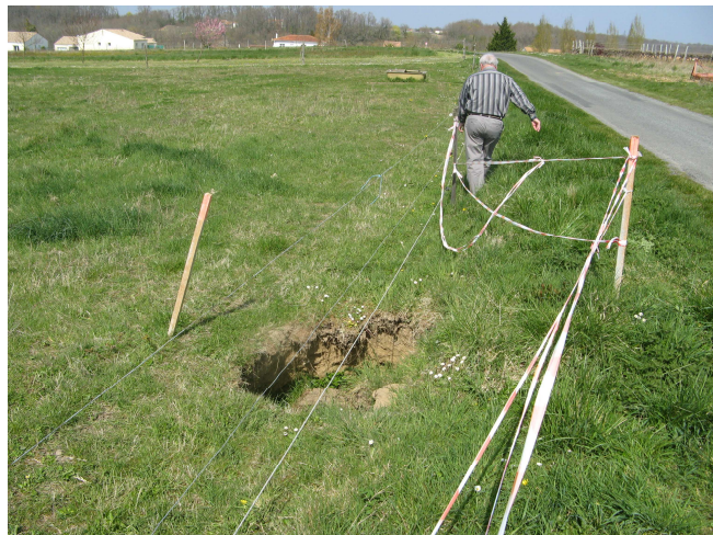
Illustration 23 - Effondrement, commune de Fontcouverte (17)
