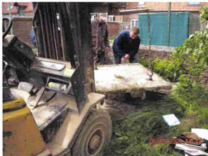
Figure 2 : Exemple d'accessibilité difficile
