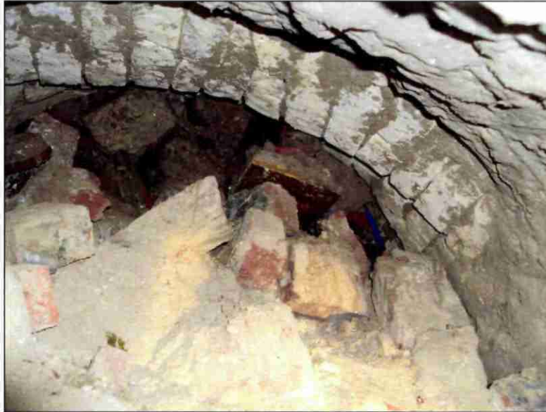
Photo 4 : Voute à redents (maçonnerie en moellons de craie) en direction de la cour intérieure (vers le SW)
