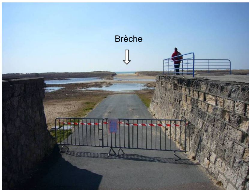
Figure 20 : Brèche dans la dune par élargissement durant Xynthia d'un sentier d'accès à la plage (La Faute-sur-Mer)
