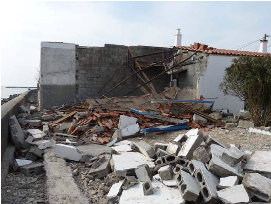
Figure 26 : Effet de l'attaque des vagues
