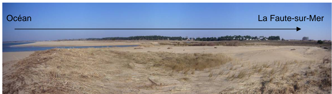
Figure 18 : Brèche de la Belle Henriette (La Faute-sur-Mer)
