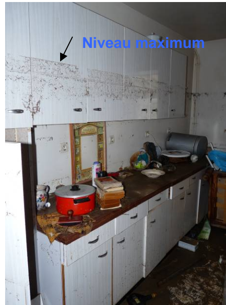
Intérieur d'une maison d'Aytré. A noter le niveau maximum de submersion atteint (2m environ)
