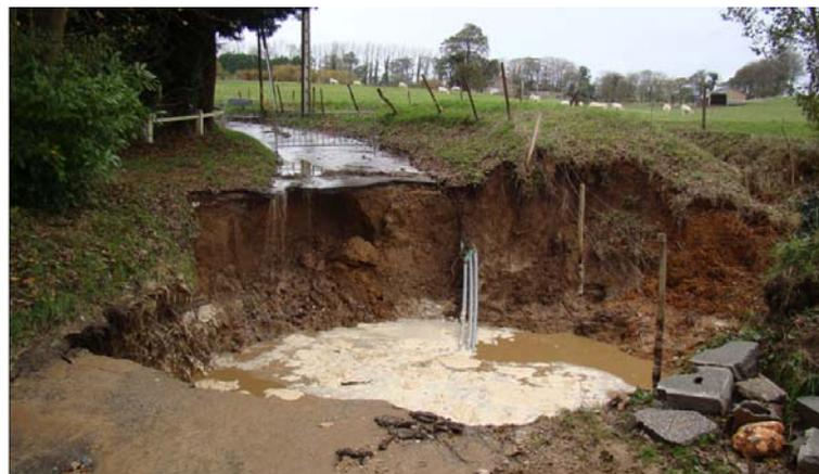
**Doline Bétoire n°10079** : effondrement du 04/11/2009 au niveau d'une route à Saint Jouin de Bruneval – diamètre de l'ordre d'une 10aine de mètres (observation du 06/11/2009) – Bétoire recevant les eaux des talwegs inondés à l'amont
