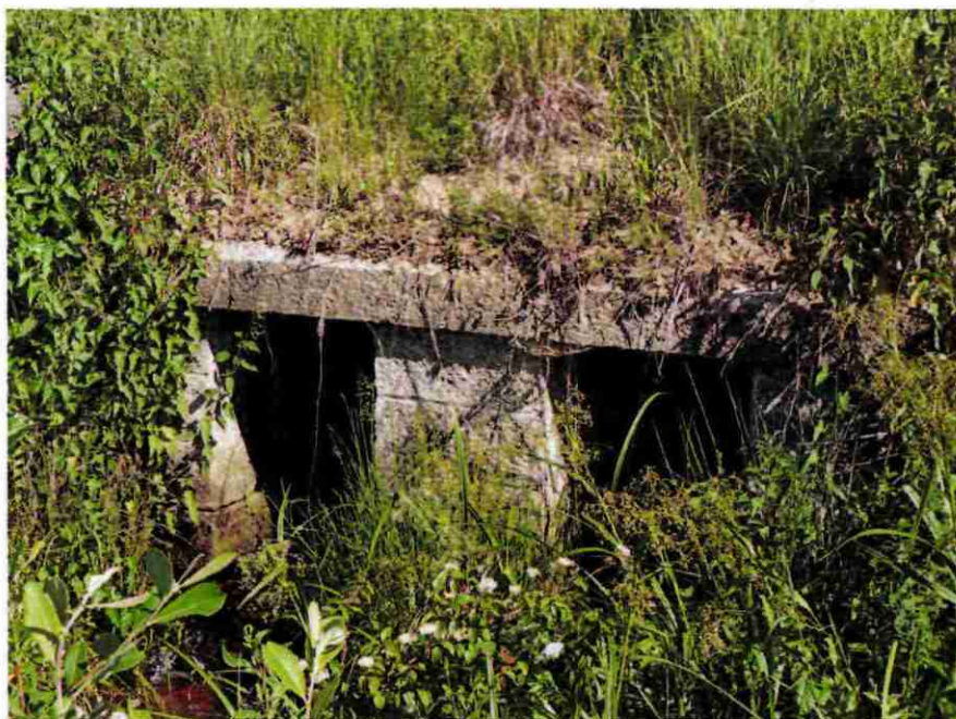
Illustration 14 : Photographie d'une sortie d'aqueduc, sur la commune de Viersat
