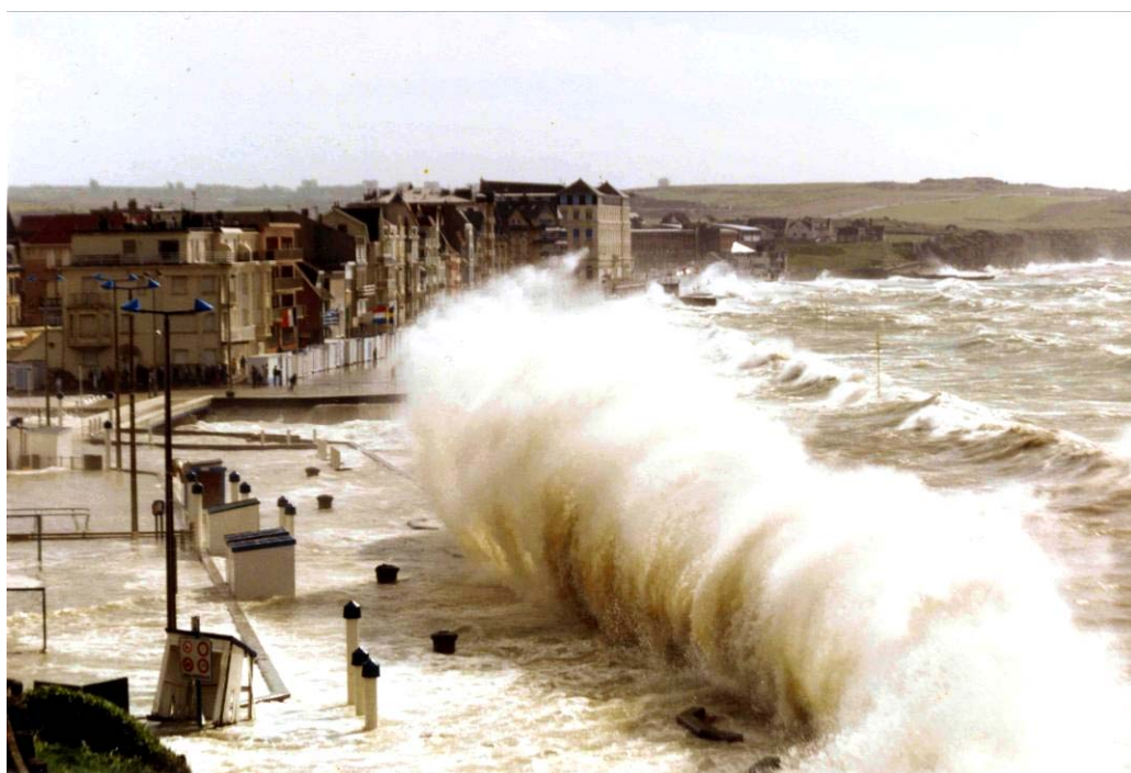
Figure 2 - Submersion marine dans une zone urbaine (Wimereux, Nord) avec surverse au-dessus d'ouvrage (02/1990 ; Photo Jean Celié).
