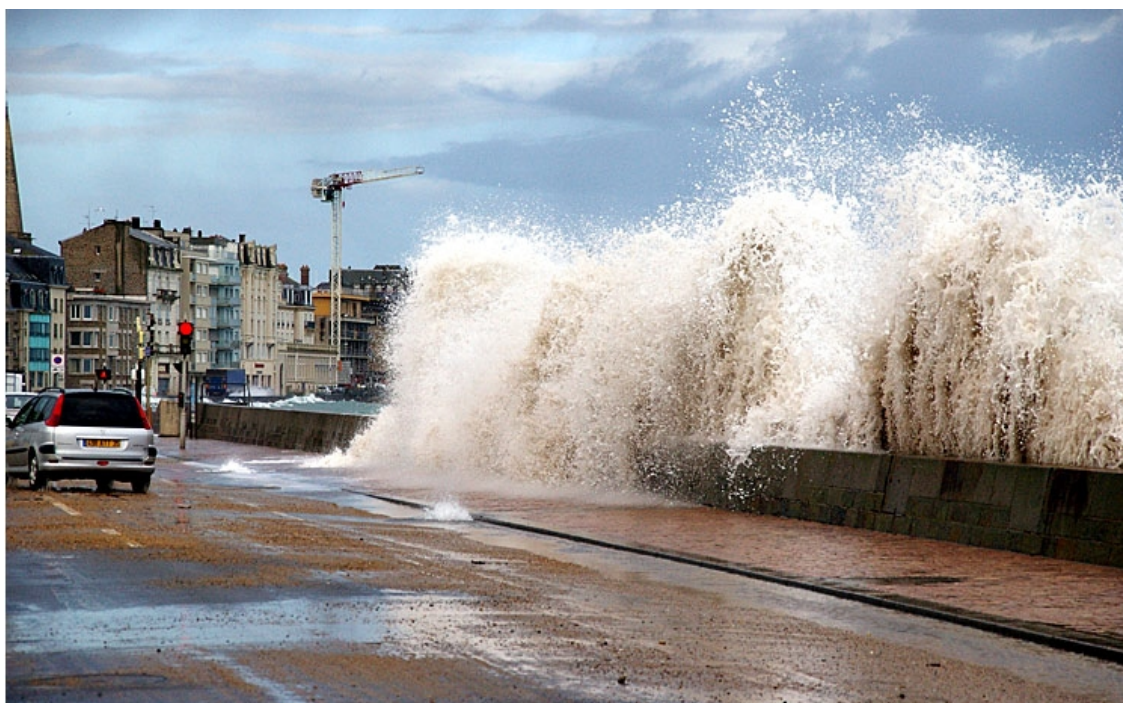
Figure 26 - Illustration de la surverse marine par dessus un ouvrage de protection lors de la tempête Johana de Mars 2008 (Saint-Malo).
