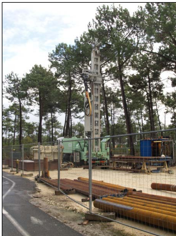
Illustration 5 : Préparation de la plate-forme
