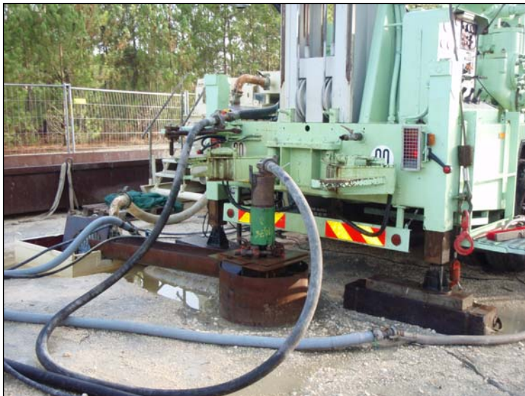
Illustration 8 : Préparation de la cimentation du tubage 9 5/8
