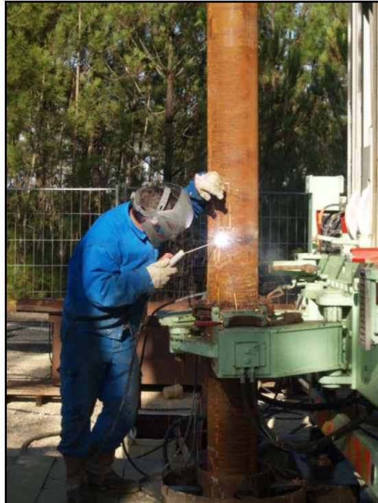
Illustration 7 : Soudure du tubage 9 5/8
