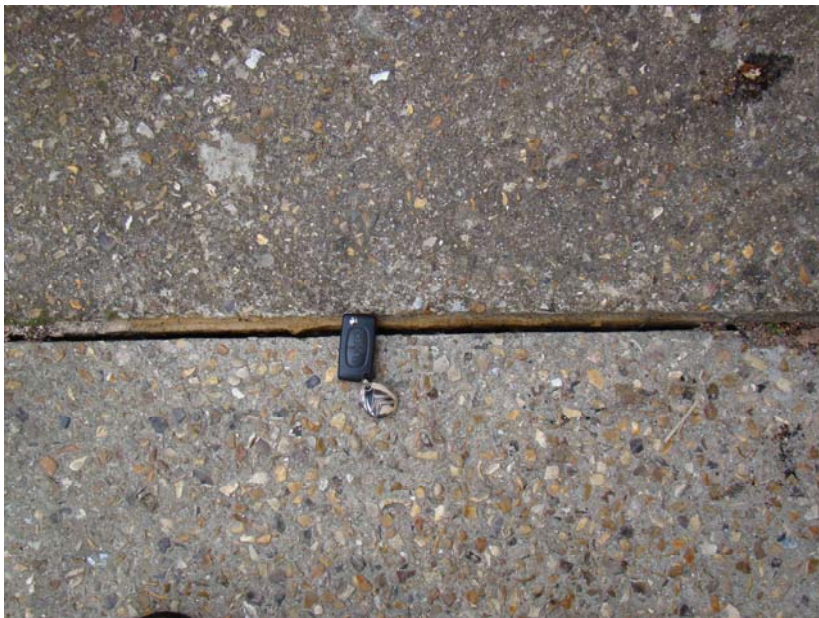
Photo 16 : Rejeu récent entre les dalles de la terrasse (sud de la maison).
