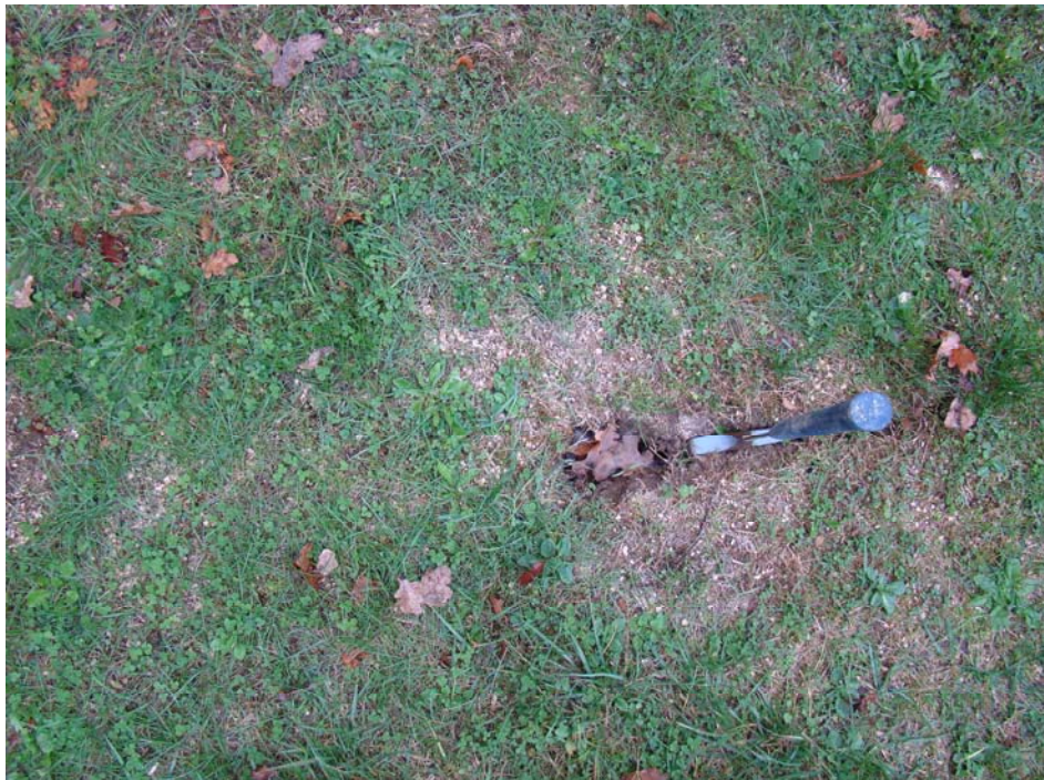
Photo 6 : Fissure dans le jardin.
