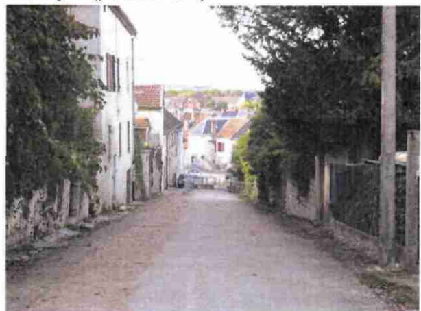
Illustration 8 : vue amont de la rue des Carrières (photo BRGM).
