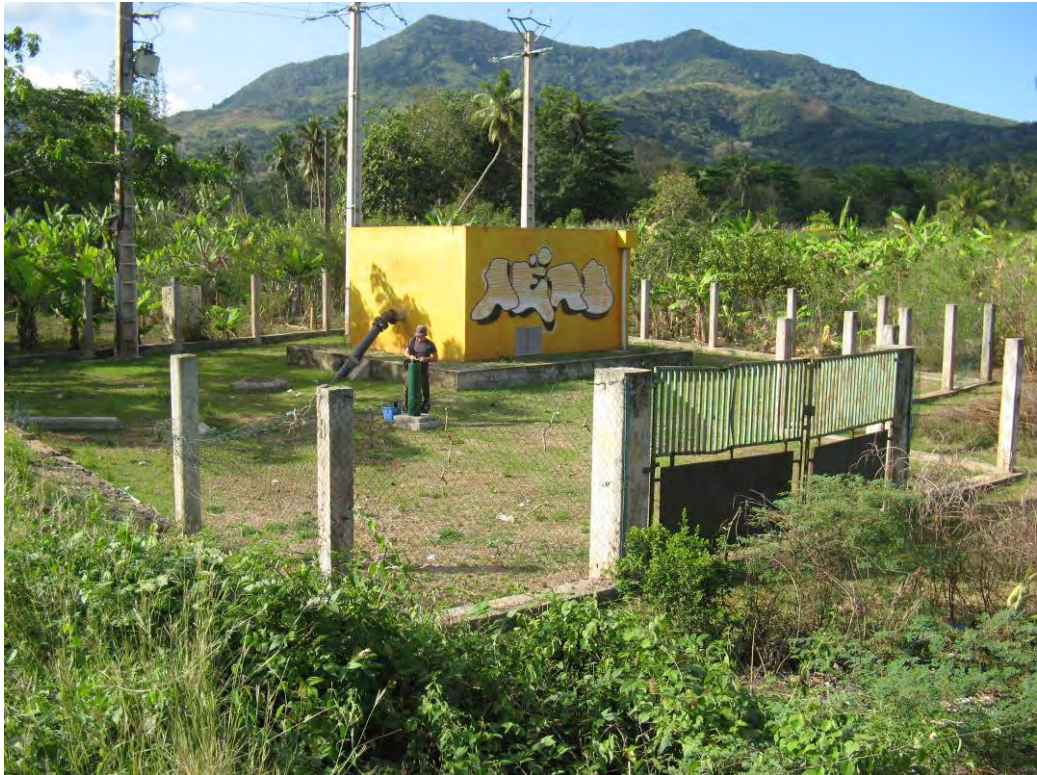
Illustration 16 - Forage de M'réréni 2 (dans le bâtiment jaune) et piézomètre de M'réréni (tube acier vert) (photographie BRGM du 25 septembre 2009)
