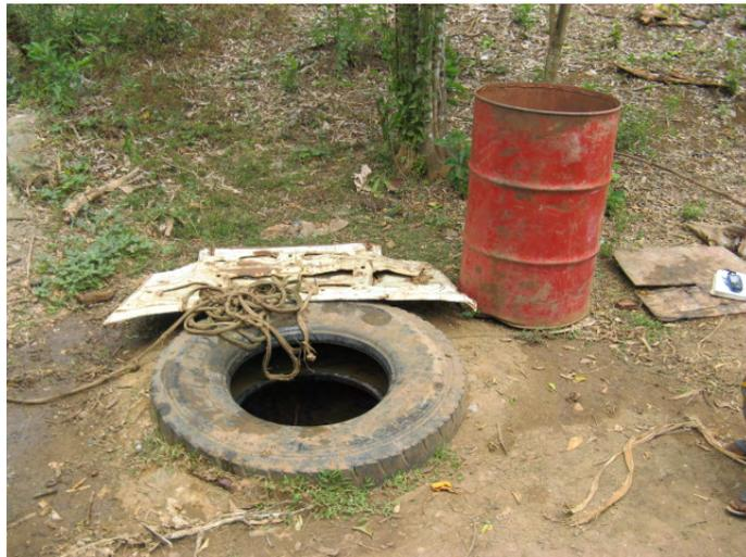
*Illustration 50 : Puits localisé à moins de 50 m à l'amont du forage Kawéni F2. On note l'absence d'une margelle de protection et le moyen rudimentaire utilisé pour l'extraction de l'eau : la corde traîne par terre à proximité du puits, là où viennent s'abreuver les zébus (photo BRGM du 21 septembre 2009)*
