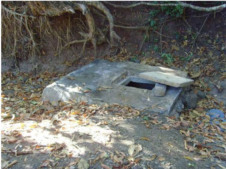
*Illustration 52 : Puits localisé dans la ravine Mro Oua Kaouenliajoli, à moins de 150 m à l'amont du forage Kawéni 3 10 pouces (photo BRGM du 15 juin 2009). La hauteur de la margelle n'empêche pas le déversement d'eaux de surface à l'intérieur lors de la saison humide (objectif qui est peut-être recherché par son concepteur)*
