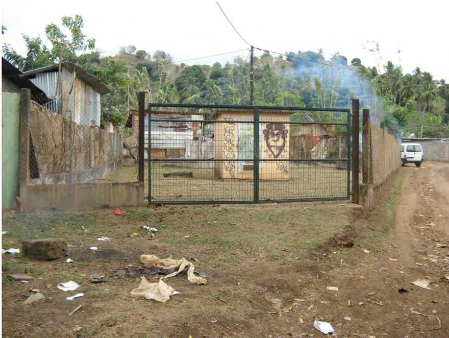
*Illustration 29 : Environnement immédiat du forage Kawéni F1 : la bâtisse abrite les vannes, la commande de la pompe du forage. Le forage se situe au fond à droite de l'enclos.
