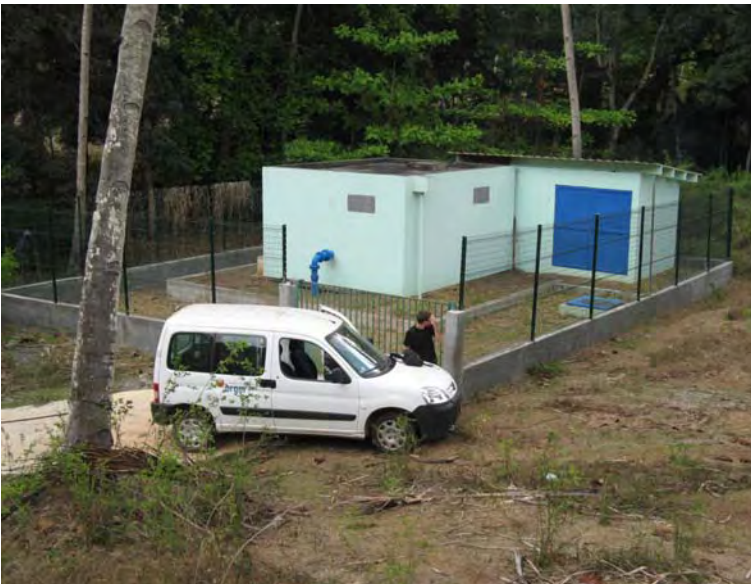
Illustration 20 - Forage de M'tsangamouji 1 (photographie BRGM du 17 septembre 2009)
