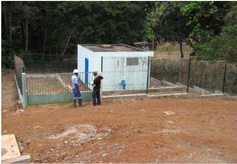
Illustration 21 - Forage de M'tsangamouji 2 (photographie BRGM du 17 septembre 2009)
