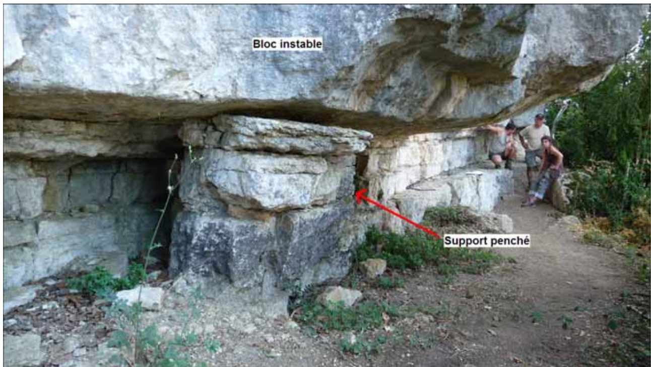
Illustration 6 : Vue sur le support du bloc – zone C – Photo BRGM
