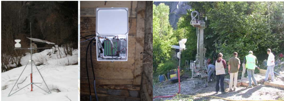
Figure 43 : Station météo, station d'acquisition Campbell installée sur le site permettant des acquisitions à distance en continu via des interrogations GSM, et activités de forage.
