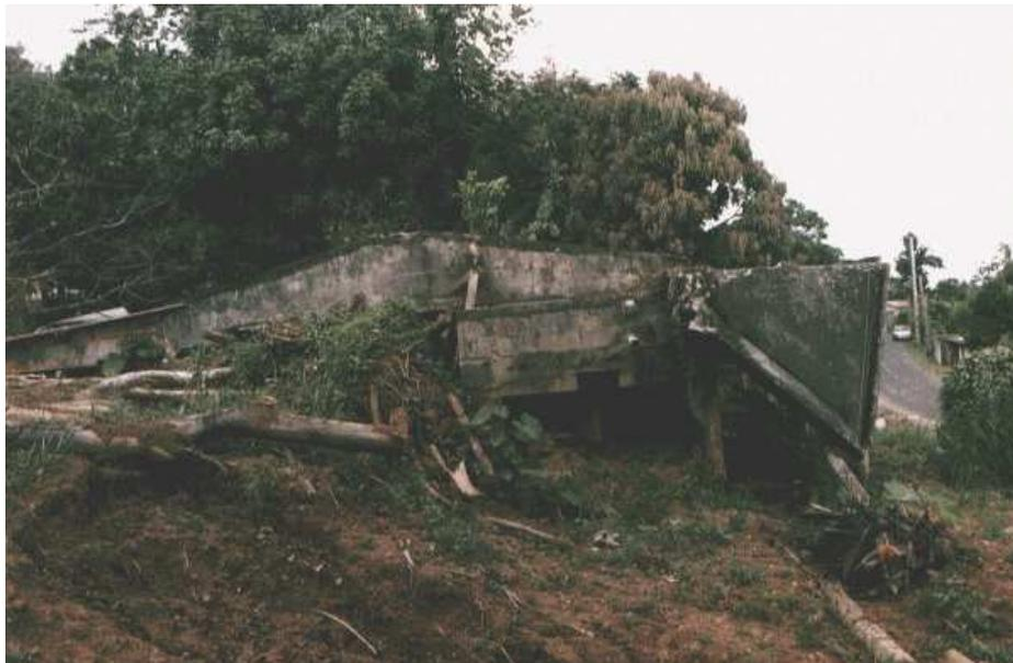
*Figure 63: Maison détruite par un glissement situé en amont*
