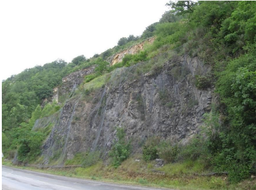
Illustration 22 : Eboulement d'une falaise sur la commune de Sabarat
