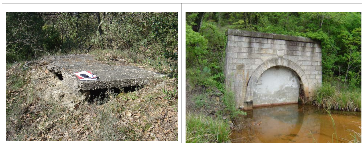
Figure 5 - a. Puits bouché par une dalle en béton insuffisamment dimensionnée ; b. Exemple de galerie bouchée (Grand'Combe).
