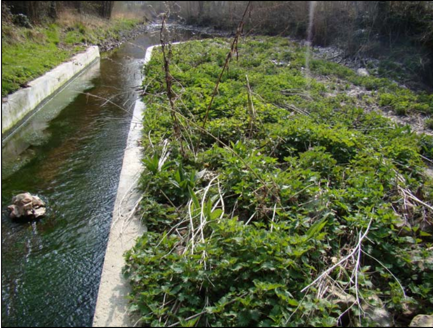
Photo 10 : Prise de vue sur le début du Sec-Iton, en eau le jour de la visite. Section de l'Iton aménagé par un auget.
