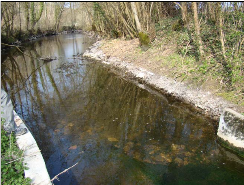
Photo 11 : Prise de vue sur le début du Sec-Iton, en eau le jour de la visite. Section de l'Iton aménagé par un auget. On note sur les berges la marque de niveaux d'eaux supérieures (traces blanches)
