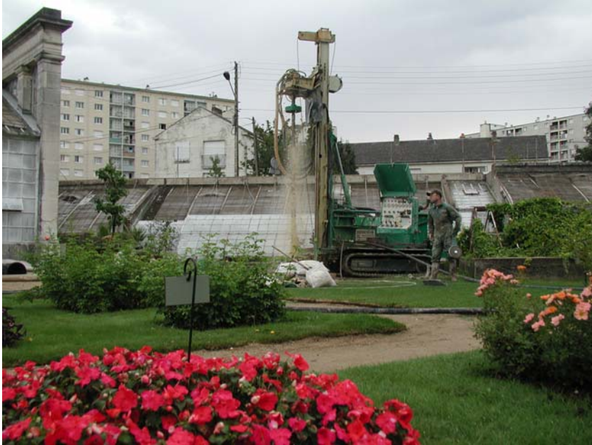
Illustration 18 - Foration du piézomètre du Jardin des Plantes.
