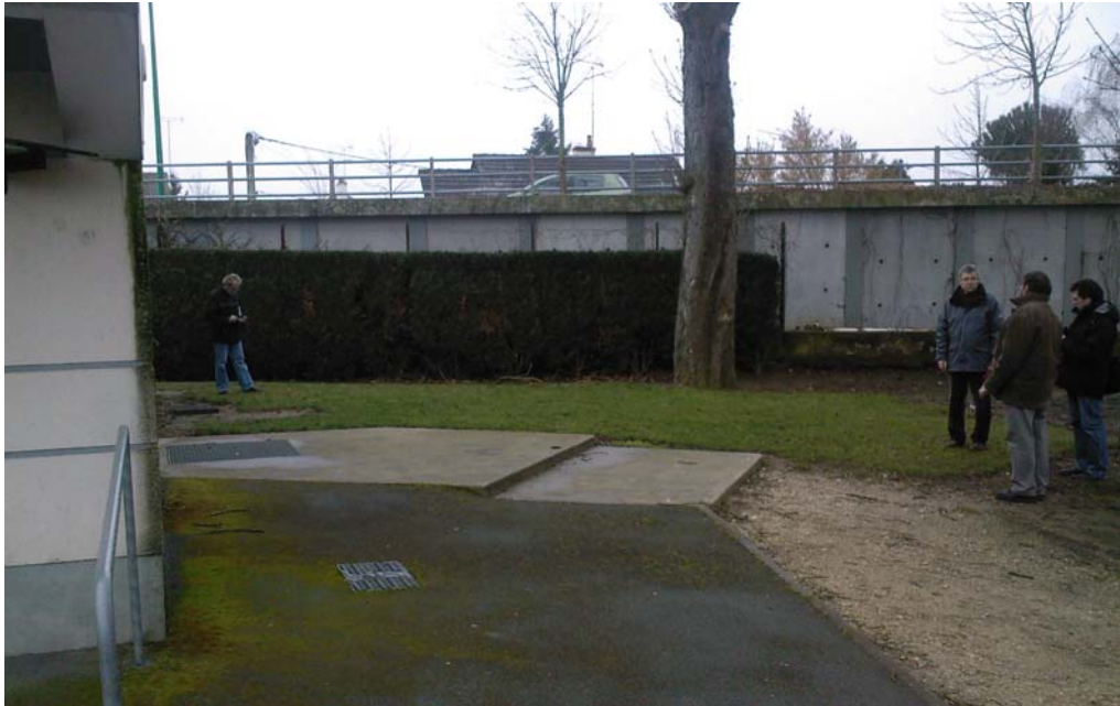
Illustration 10 - Emplacement du piézomètre PZ 1 - Piézomètre de l'Hippodrome (voir ill. 9).
