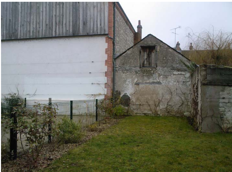
Illustration 13 - Emplacement du piézomètre PZ 4 - Piézomètre du Parc du Moins Roux (voir ill. 9).
