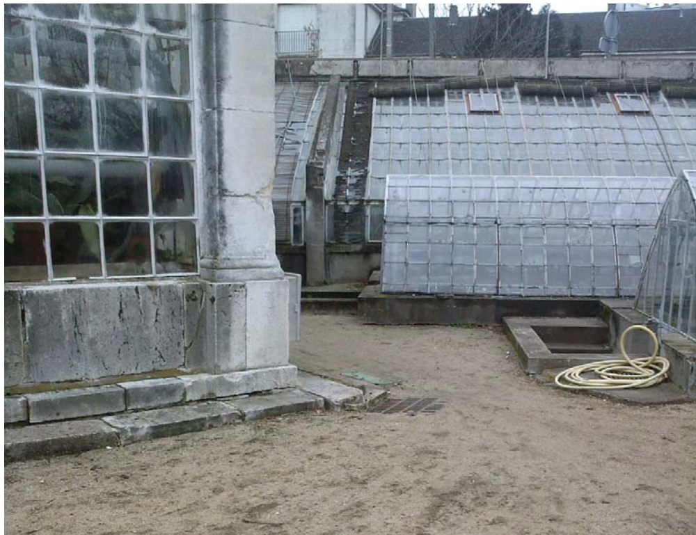
Illustration 11 - Emplacement du piézomètre PZ 2 - Piézomètre du Jardin des Plantes (voir ill. 9).
