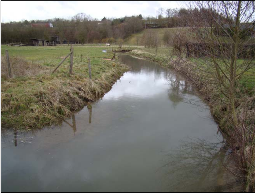
Photo 8 : Prise de vue de la Varenne depuis le pont du Thil, à l'amont immédiat d'un ouvrage hydraulique. La baisse du niveau est moins visible sur cette photographie, cette observation est confirmée par le technicien du SIBVV.
