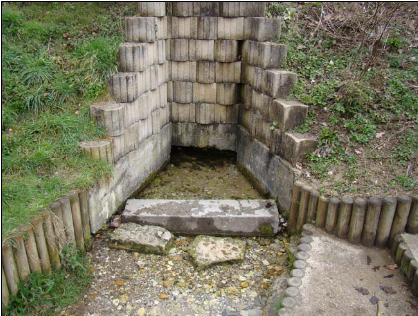
Photo 11 : Prise de vue d'une source rejoignant le petit affluent (Photo 10). Un captage AEP est implanté immédiatement à l'amont sur le versant.
