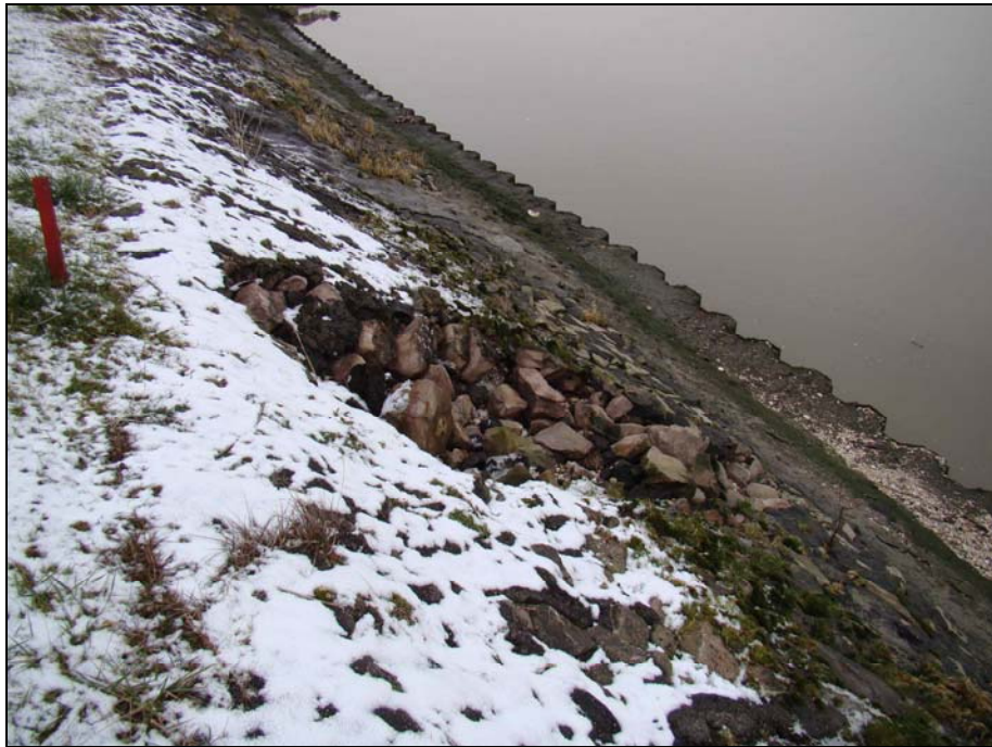
Photo 1 : Vue du type de désordre pouvant affecter le perré.
