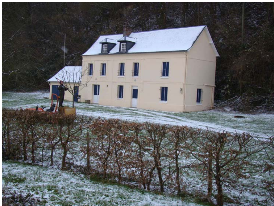
Photo 10 : Vue du gîte protégé par la berge érodée.
