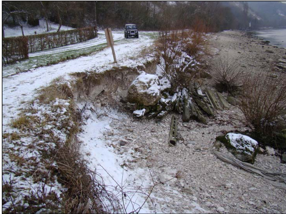
Photo 9 : Niche d'érosion visible à l'ouest de la commune de Barneville-sur-Seine.
