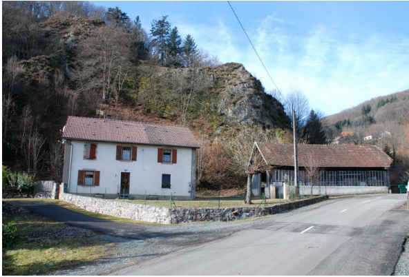
Constructions sous falaise à Auxelles-le-Haut (90) (photo BRGM).
