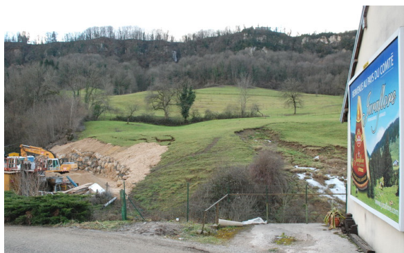
Glissements de terrain à Salins-les-Bains (39) (photo BRGM).
