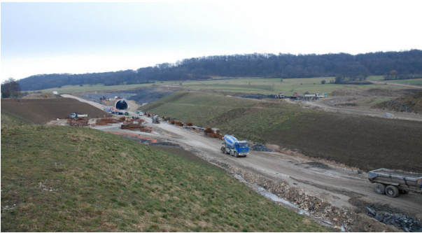
Configuration susceptible de créer un effet de site topographique à Chavanne (70), tête du tunnel de la LGV Rhin-Rhône dimensionné pour ce phénomène (photo BRGM).
