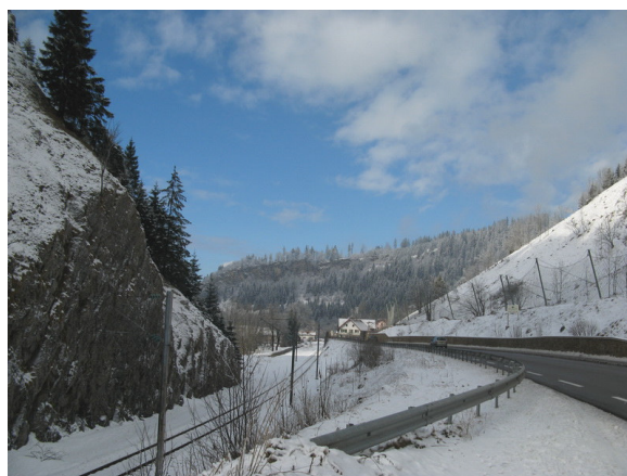
Risques d'éboulements dans la cluse de Joux (25) (photo BRGM).
