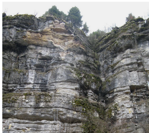
Eboulement en falaise au cirque de Consolation (25) (photo BRGM).
