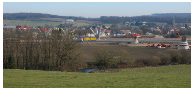
Configuration susceptible de créer un effet de site dans la plaine alluviale de la Savoureuse (90), traversée par le viaduc de la Savoureuse de la LGV Rhin-Rhône (photo BRGM).
