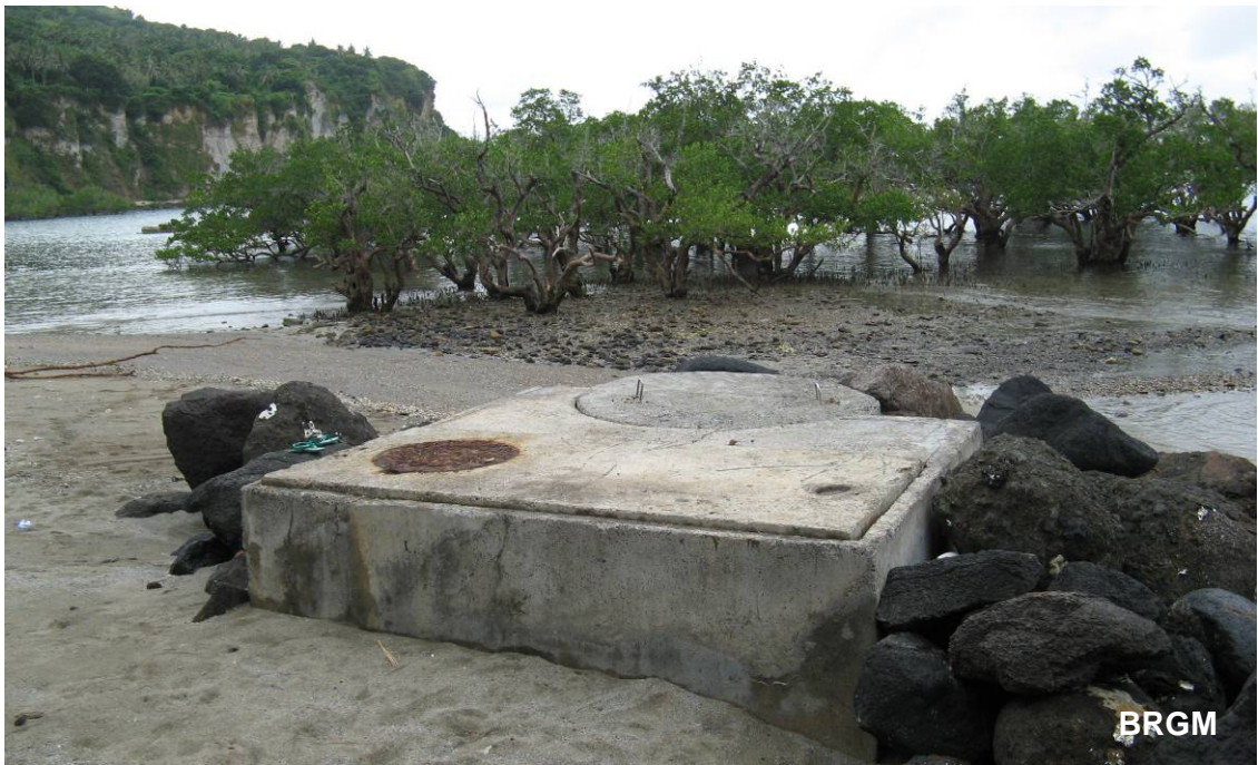
Illustration 2 : Fosse de pompage des eaux marines.
