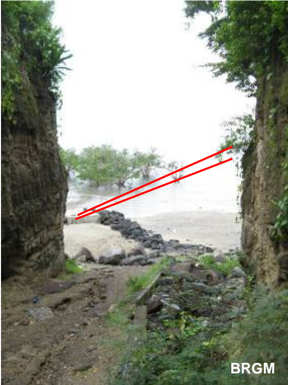
Illustration 3 : A gauche, ravine d'accès à la plage, aménagée par SOGEA. En rouge est figurée la direction de développement des drains de captage..
