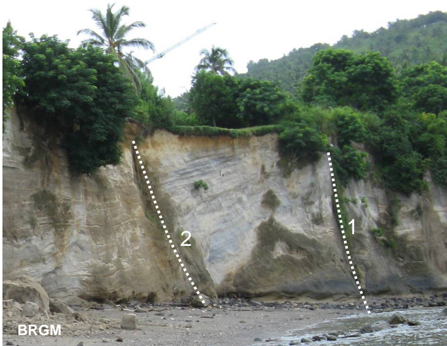
Illustration 5 : Ouvrages pluviaux du lycée (1) et de la station de dessalement (2). L'incision au sommet de la falaise est bien visible.
