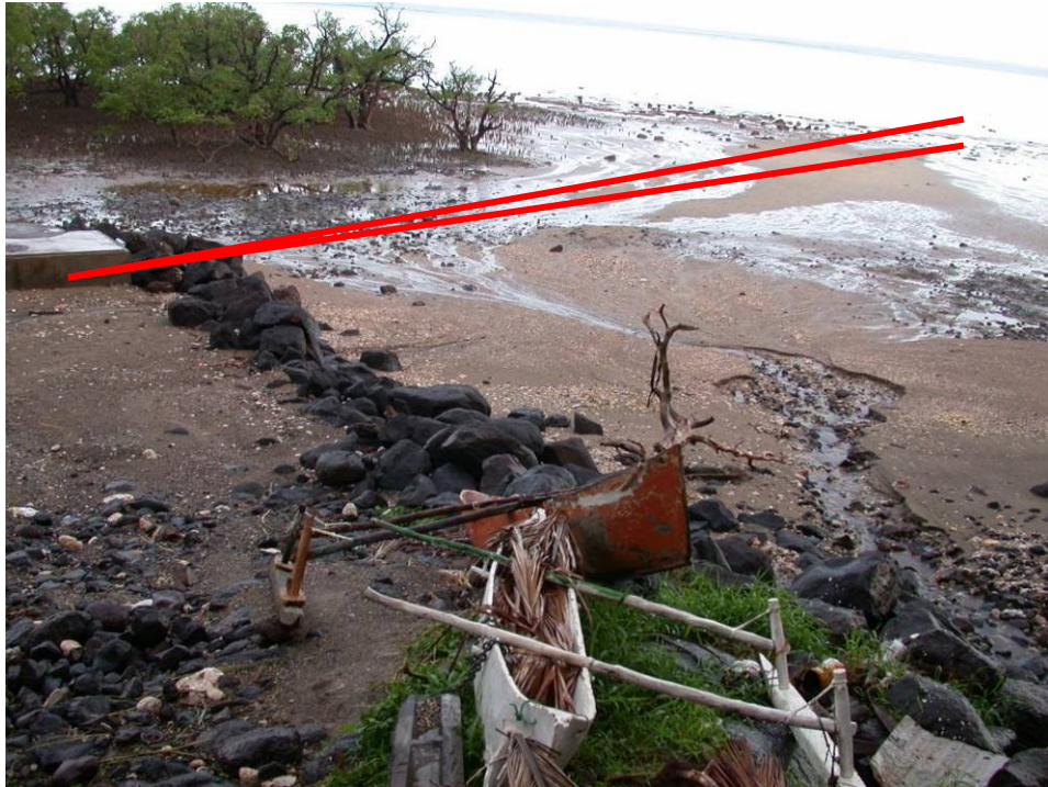
Illustration 13 : Les écoulements en provenance du parc à zébus et canalisés par la ravine viennent s'épandre sur les drains en partie découverts à marée basse, ici symbolisés en rouge (photographie SOGEA).
