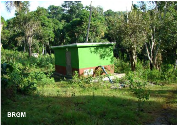
Illustration 8 : Le forage de Gouloué 1 (photographie du 4 février 2009)
