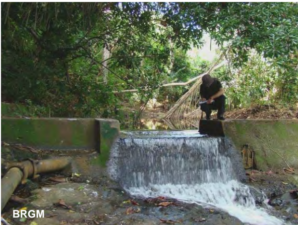
Illustration 7 : La prise d'eau de surface du Mro Oua Gouloué (photographie du 4 février 2009)
