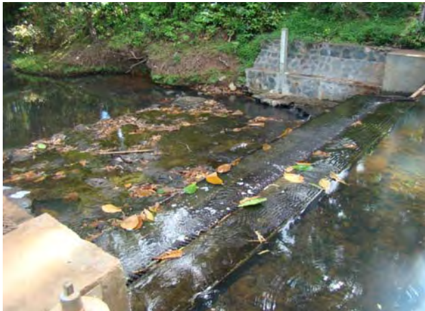
Illustration 8. Captage de Bouyouni bas. Les feuilles viennent fréquemment obstruer la grille (photographie du 4 février 2009)
