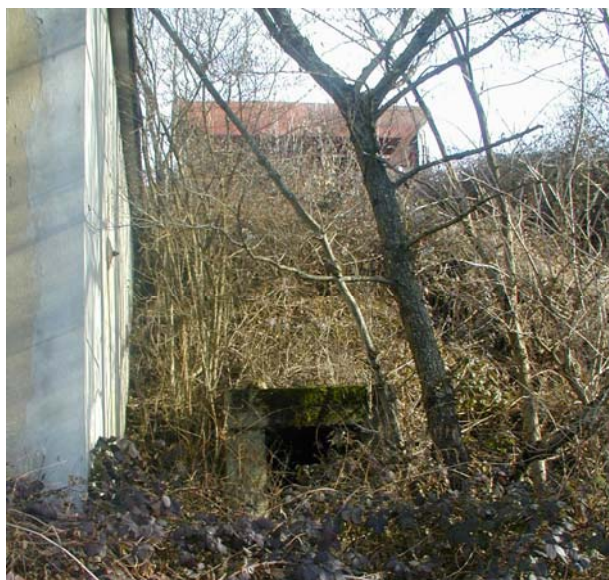
Entrée de la galerie passant sous le remblai (photo BRGM)
